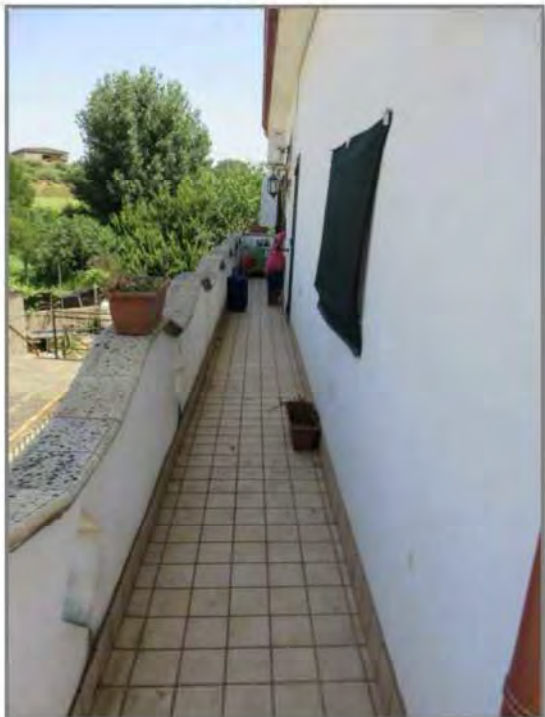
Balcone lato nord
