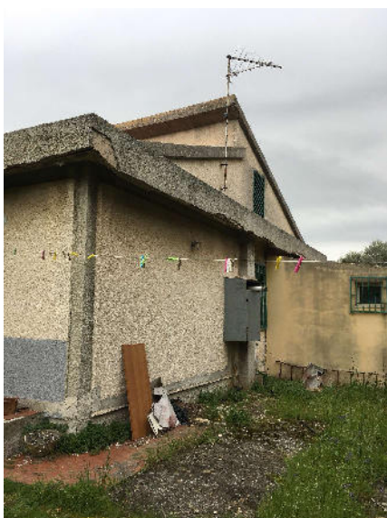
Facciata con orientamento a: nord - ovest
