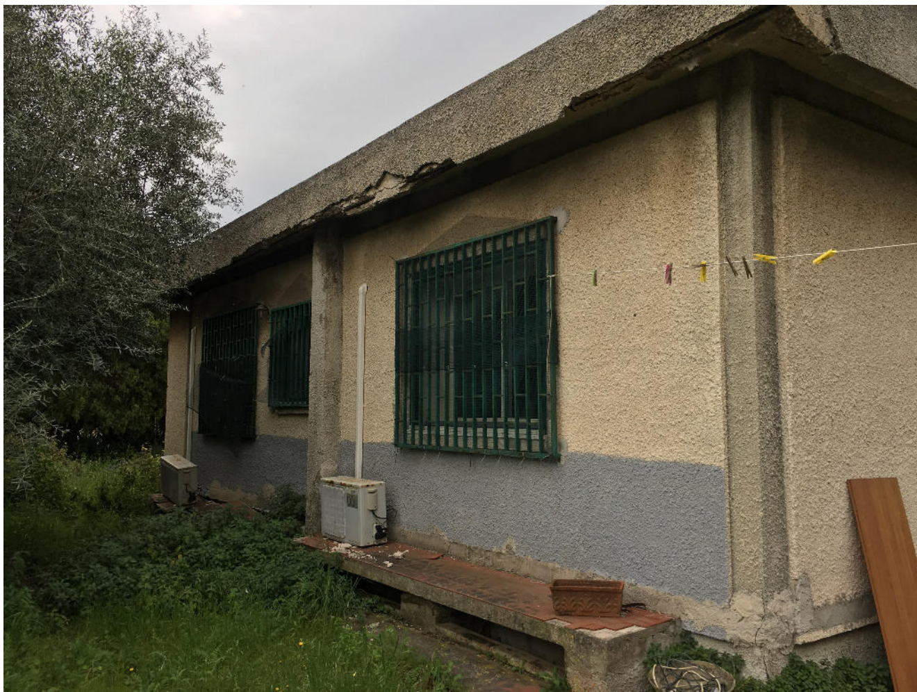
Facciata con orientamento ad est
