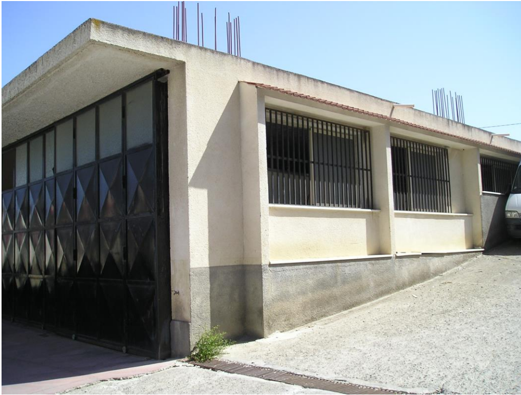
FOTO N. 5 – prospetto lato mare fabbricato "A"
