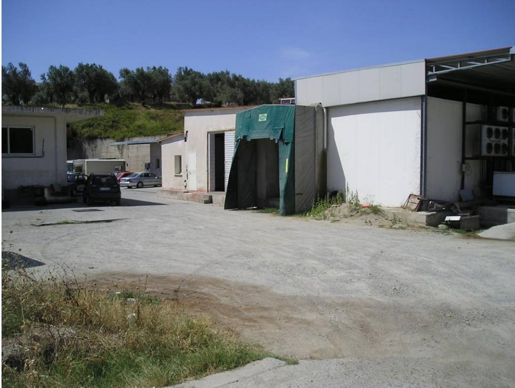
FOTO N. 2 – piazzale del complesso industriale –
