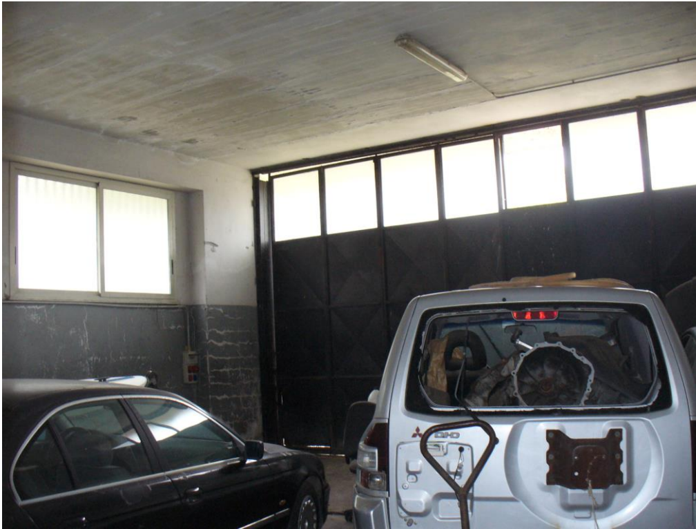
FOTO N. 7 – interno del fabbricato “A” – porta di accesso vista dall’interno-
