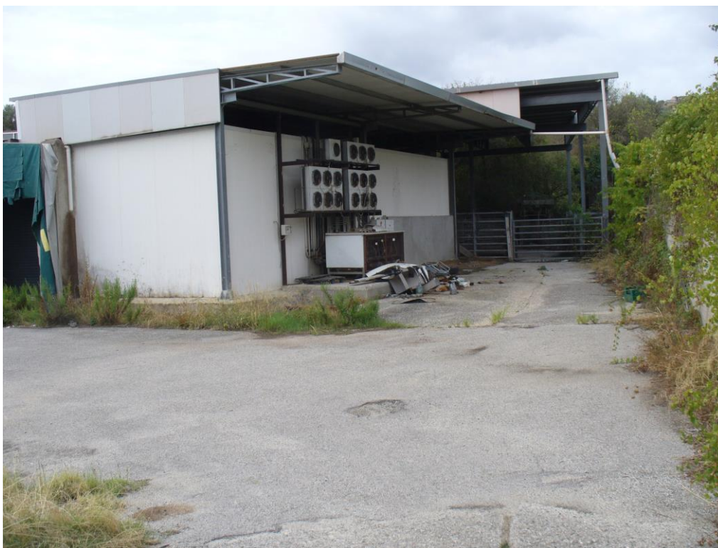
FOTO N. 15 – piazzale e tettoia –
