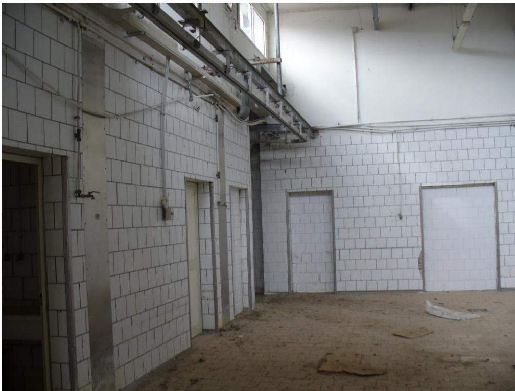
FOTO N. 13 – interni - fabbricato “B”-
