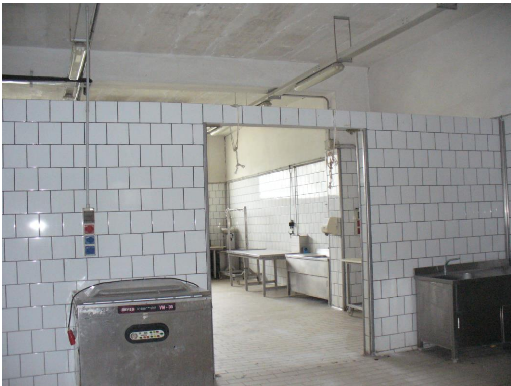
FOTO N. 10 – interno del fabbricato “A” – zona lavorazione carni –
