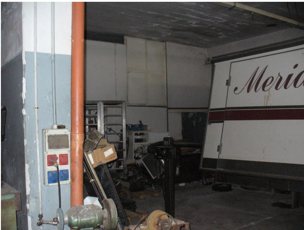
FOTO N. 8 – interno del fabbricato “A” -
