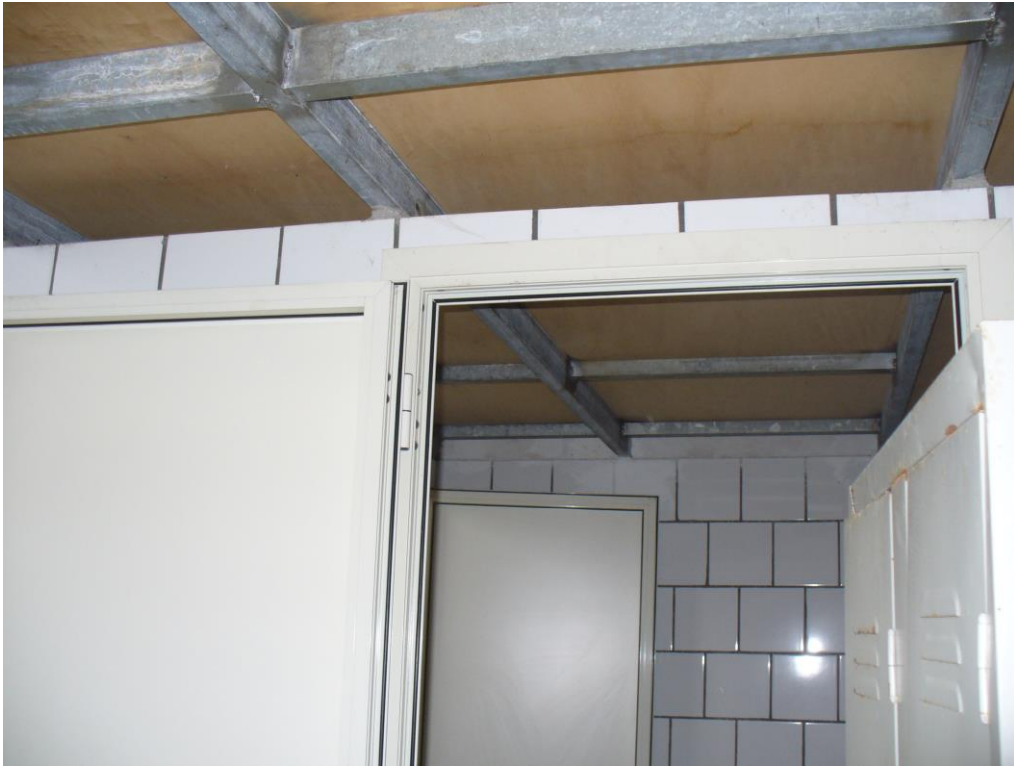
FOTO N. 9 – struttura del soppalco-
