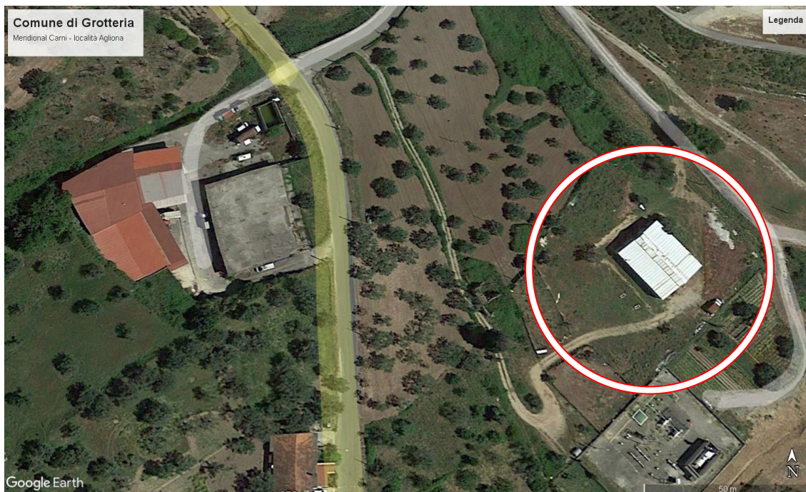
AEROFOTO N. 2 – capannone destinato a stalla- stato attuale –
