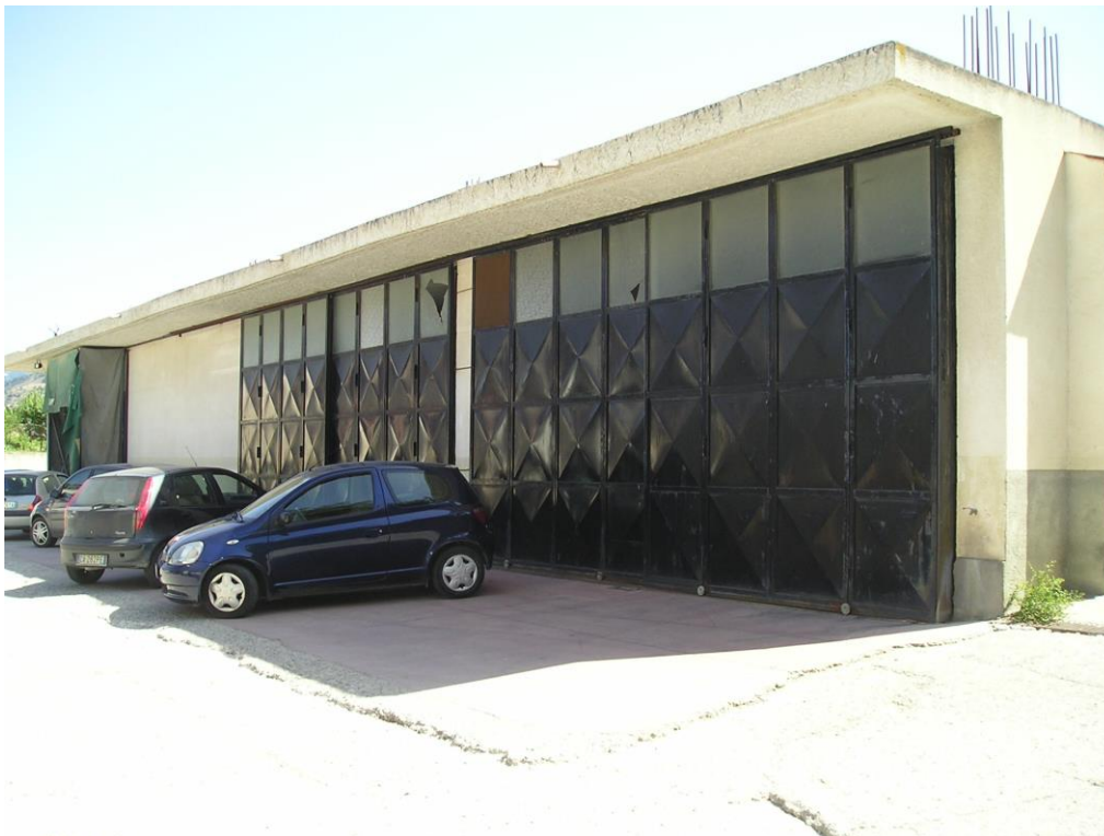
FOTO N. 4 – lato ingressi fabbricato “A” –
