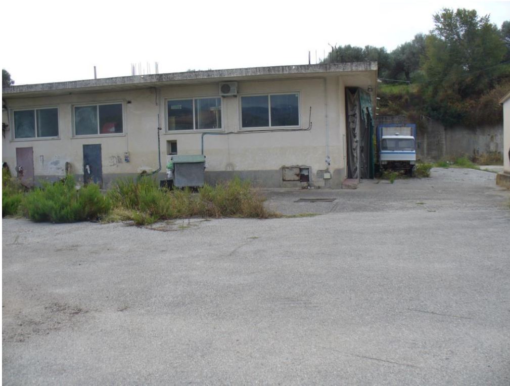
FOTO N. 3 – prospetto lato monti fabbricato “A” –
