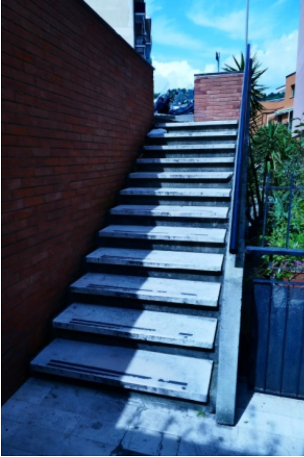
Foto 4 - Vista della scala di accesso dalla strada
