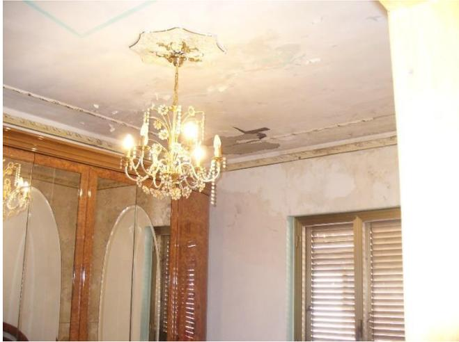
**FOTO N. 74 – infiltrazioni al soffitto –**
