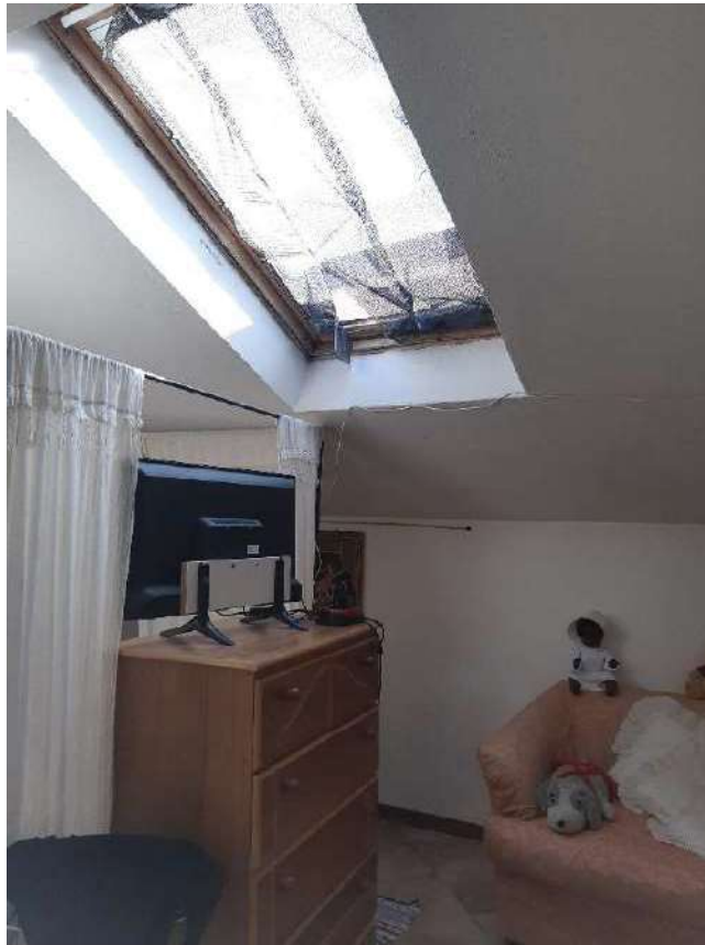
Particolare interno piano primo
