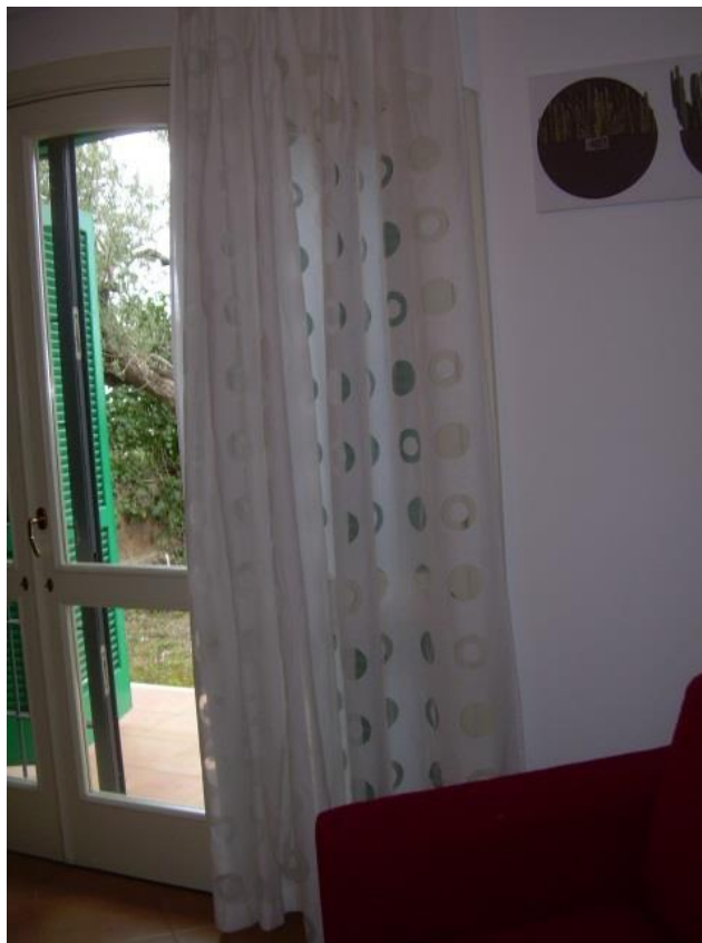
Foto n.11:infisso della porta soggiorno pranzo verso il giardino.
