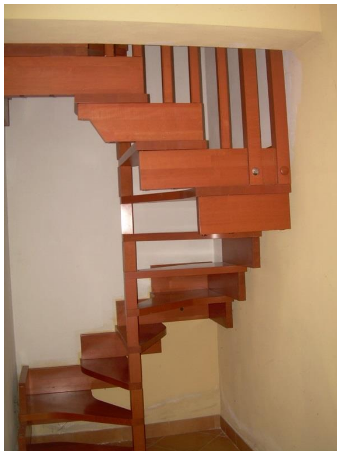
Foto n.26: scala a chiocciola in legno, in prossimità dell'ingresso all'abitazione, che dal piano terra porta alla taverna al piano seminterrato. Sopra il battiscopa e l'intonaco della muratura, si nota risalita di umidità proveniente dal sottostate pavimento.
