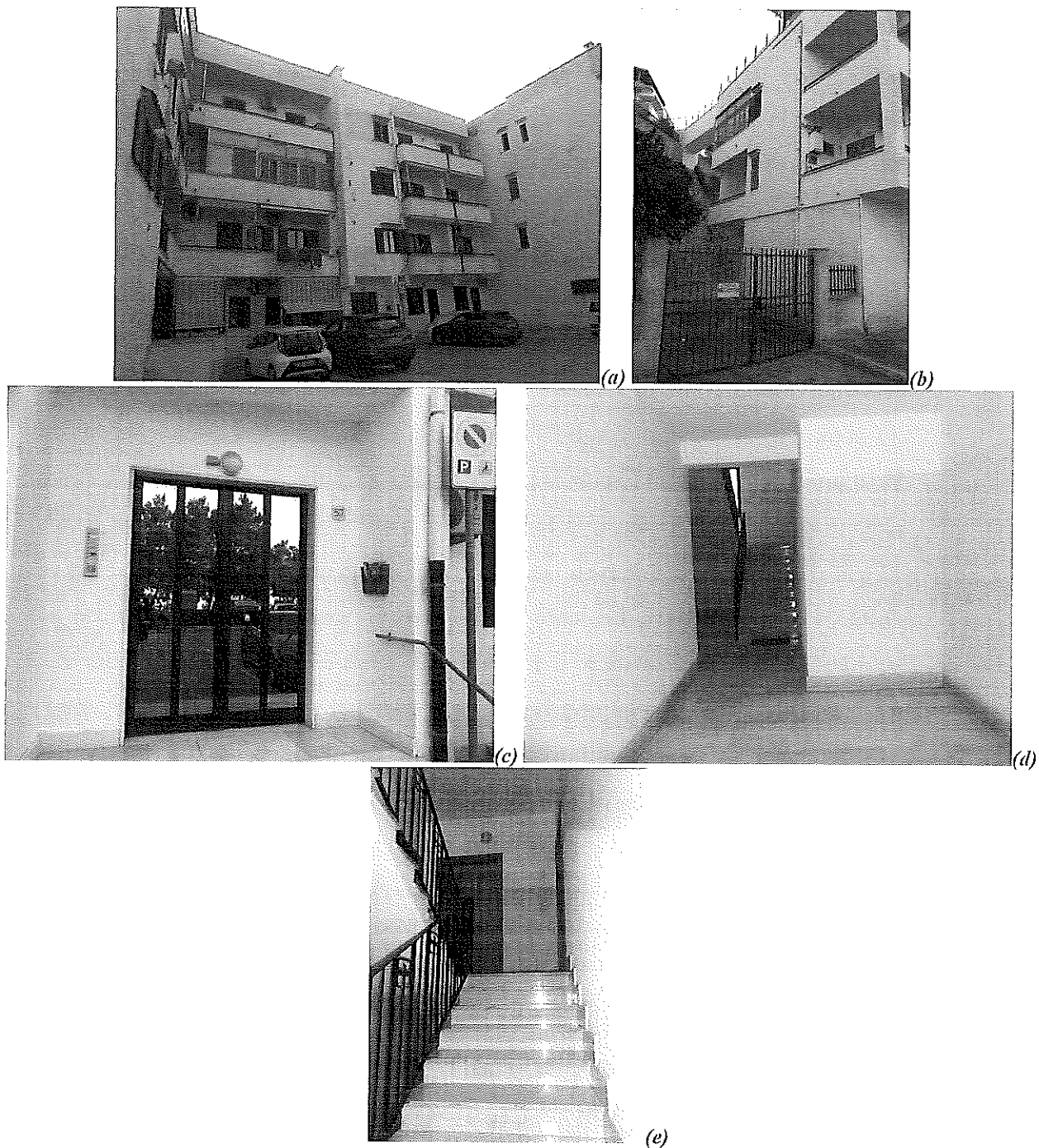
Figura n° 2. Fotografie del fabbricato ubicato in via Dante Alighieri ai numeri civici 39 - 61: facciate principali su via Dante Alighieri (a); prospetto su cortile privato (b); portone della scala B (c); androne (d); scalinata condominiale (e).
