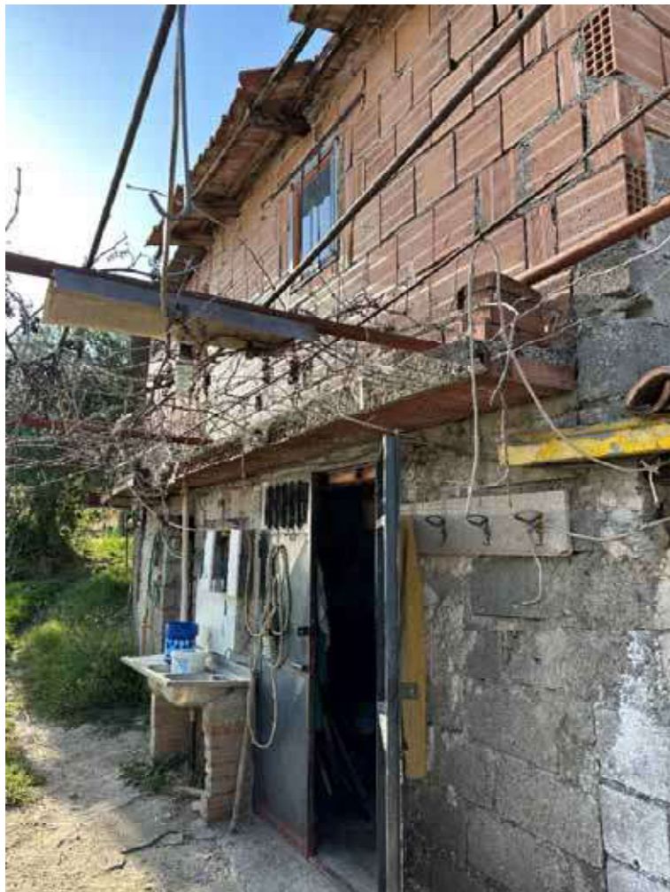
Foto 26: vista esterna fg. 4 p.lla 364 sub 2
