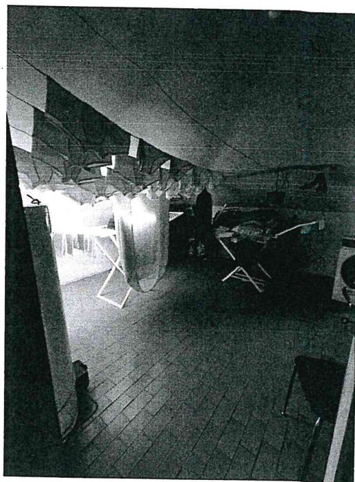
PARTICOLARI FINITURE INTERNE (LOCALE DEPOSITO P.3)
