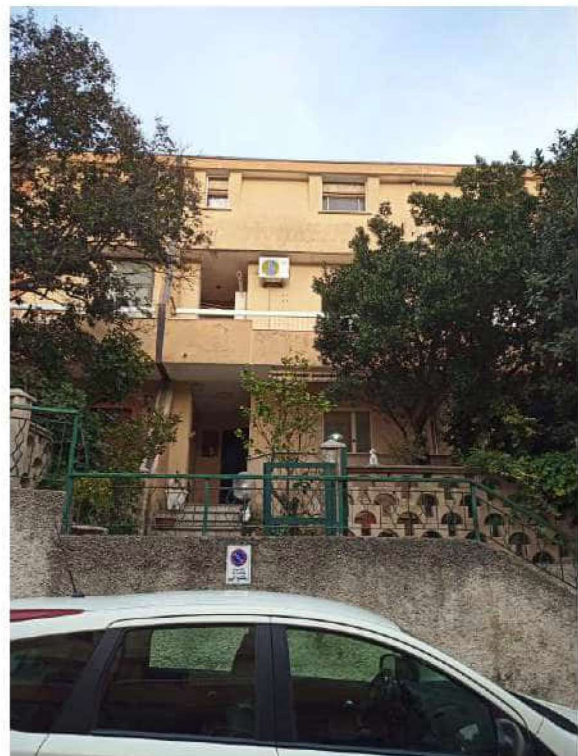
Foto 1 – Prospetto Sud - Ovest
