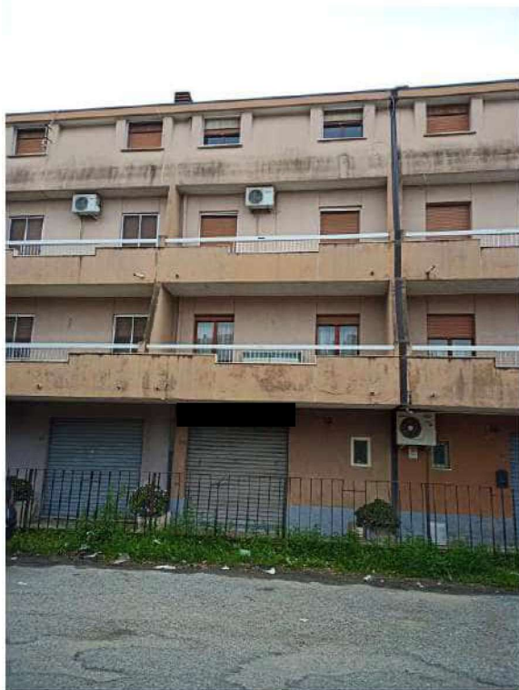
Foto 3 – Prospetto Nord - Est
