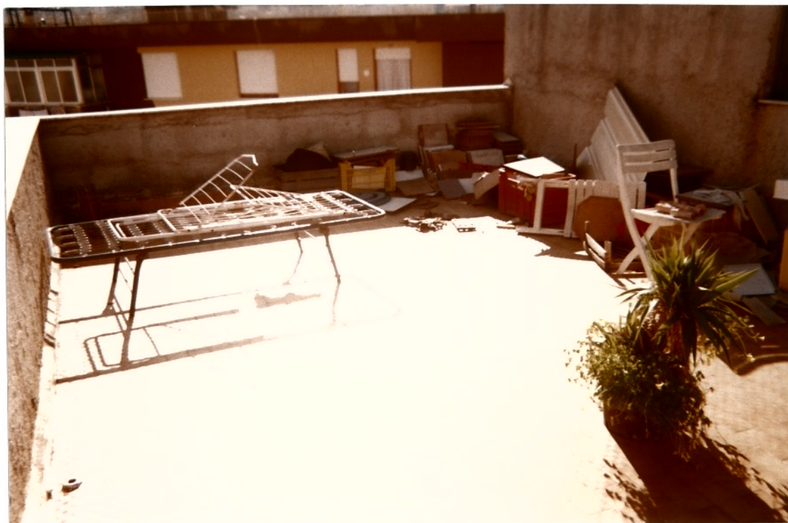
foto n. 21. Secondo piano. La terrazza di copertura della cucina.
