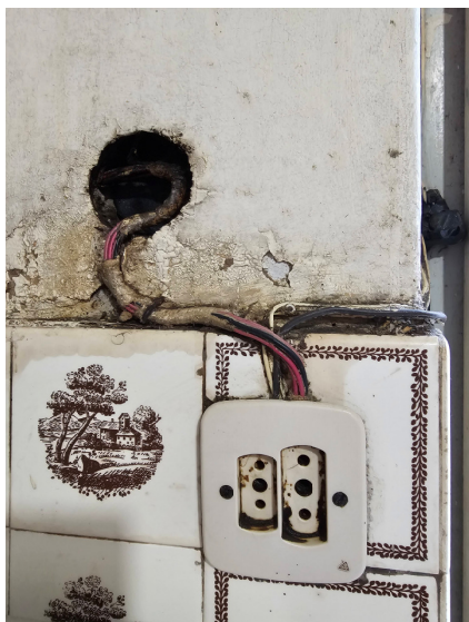
Foto 19-20-21 vetustà dell'impianto elettrico e della struttura
