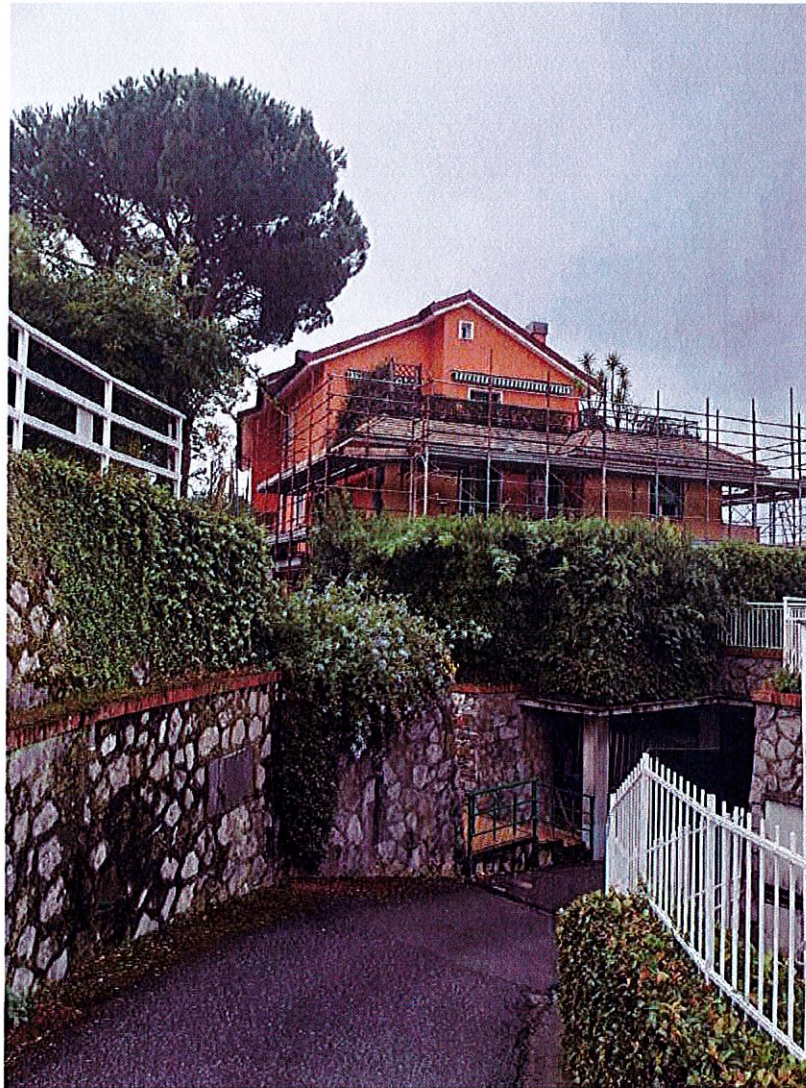
Altra vista esterna del fabbricato interessato da lavori di manutenzione straordinaria
