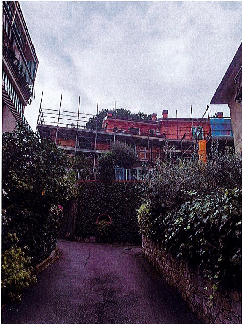
Vista esterna del fabbricato interessato da lavori di manutenzione straordinaria
