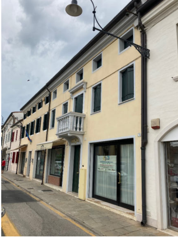
Foto n. 1 Vista del fabbricato
