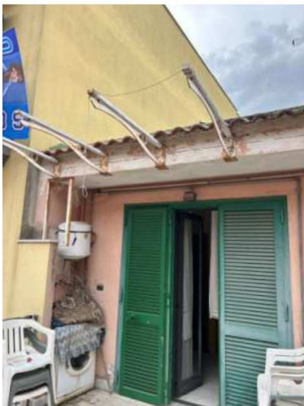
Foto n.26 – Terrazzo primo piano
