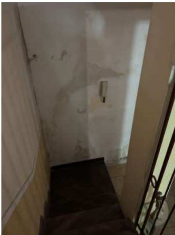
Foto n.30 – Scala di accesso al piano cantinato
