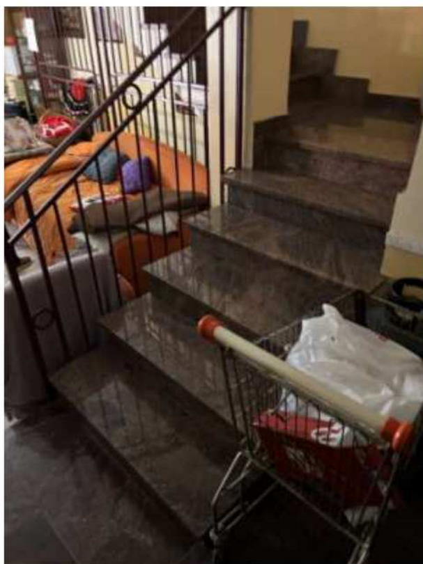
Foto n.12 – Scala di accesso al primo piano
