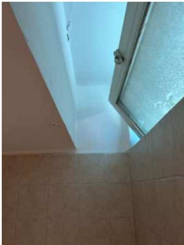
Foto n.21 – Bagno primo piano
