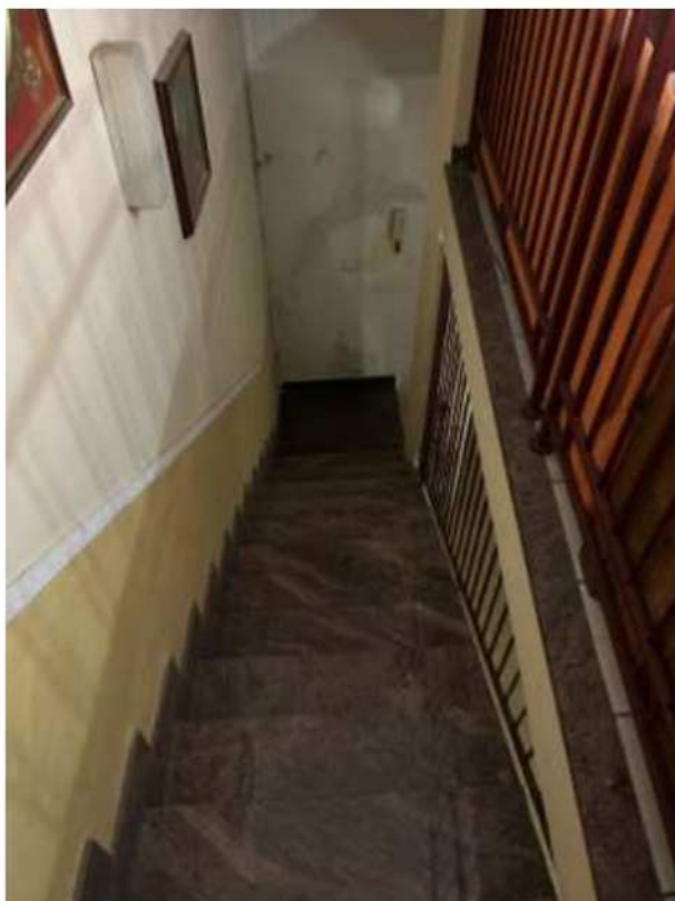
Foto n.29 – Scala di accesso al piano cantinato
