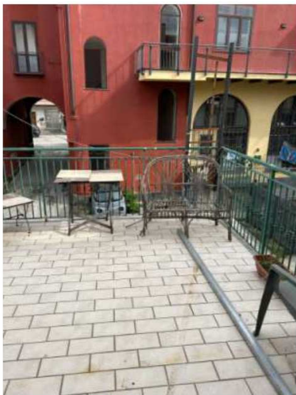
Foto n.28 – Terrazzo primo piano
