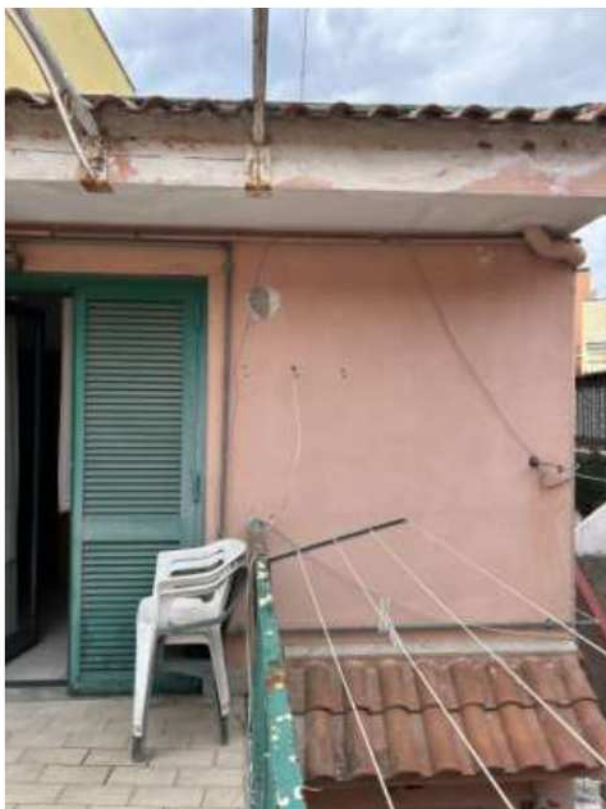
Foto n.25 – Terrazzo primo piano
