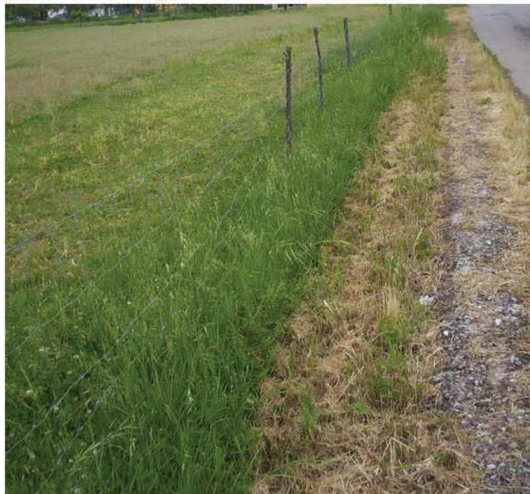
Vista particolare recinzione Lotto 1
