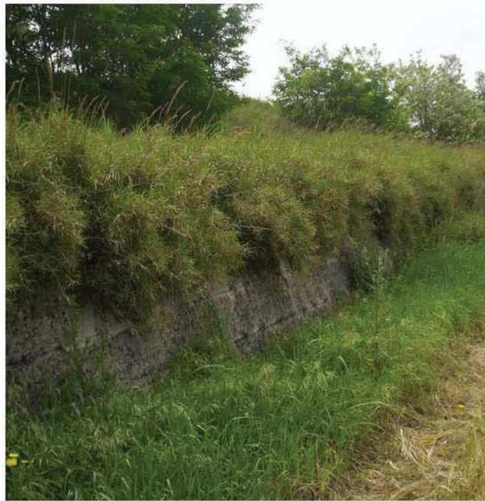
Vista particolare muro sostegno rilevato ferroviario lato strada interpoderale
