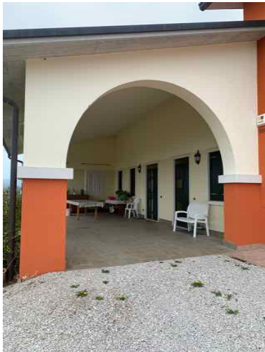
portico con ingresso comune
