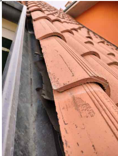
particolare della copertura
