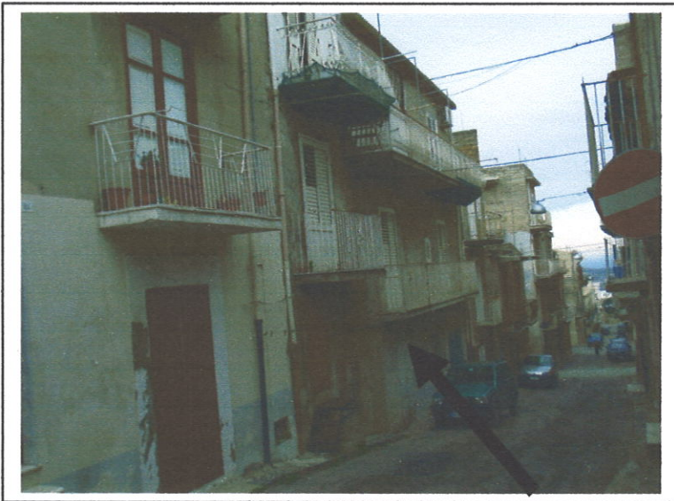
Ingresso da via Di Vincenzo
