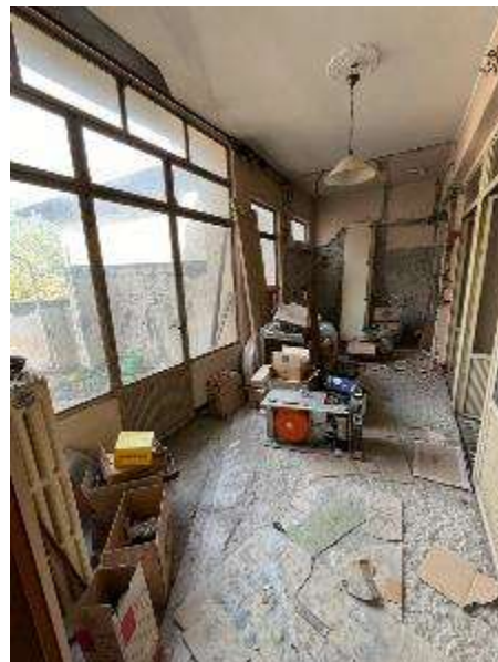
veranda con servizio igienico demolito
