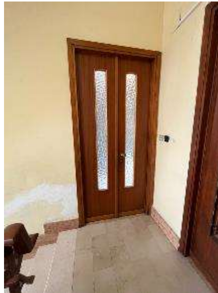
porta di accesso dal vano scala
