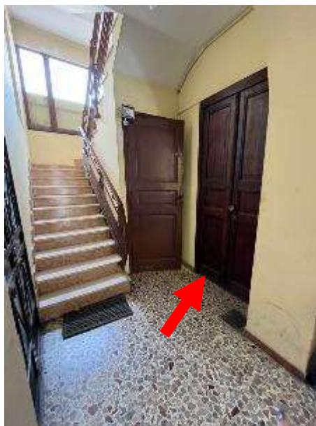
Accesso magazzino da vano scala p.T
