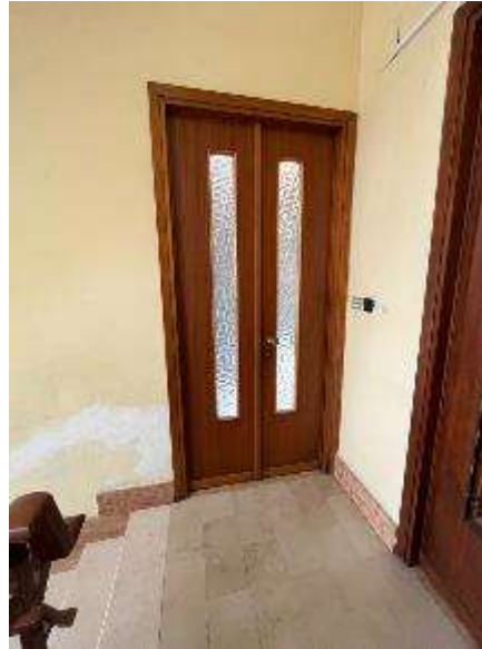
porta di accesso dal vano scala
