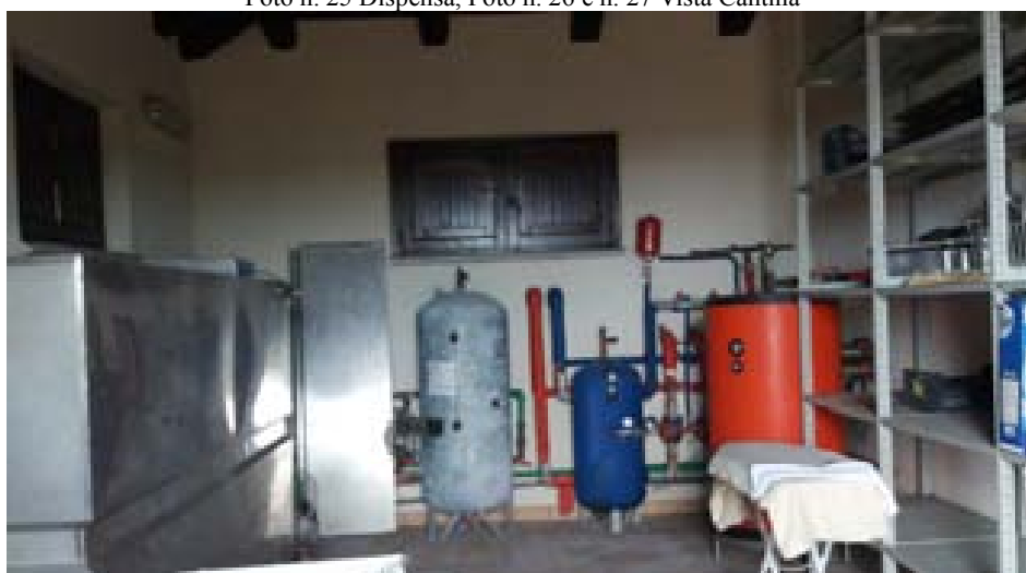
Foto n. 28 Vista vano tecnico - lavanderia
