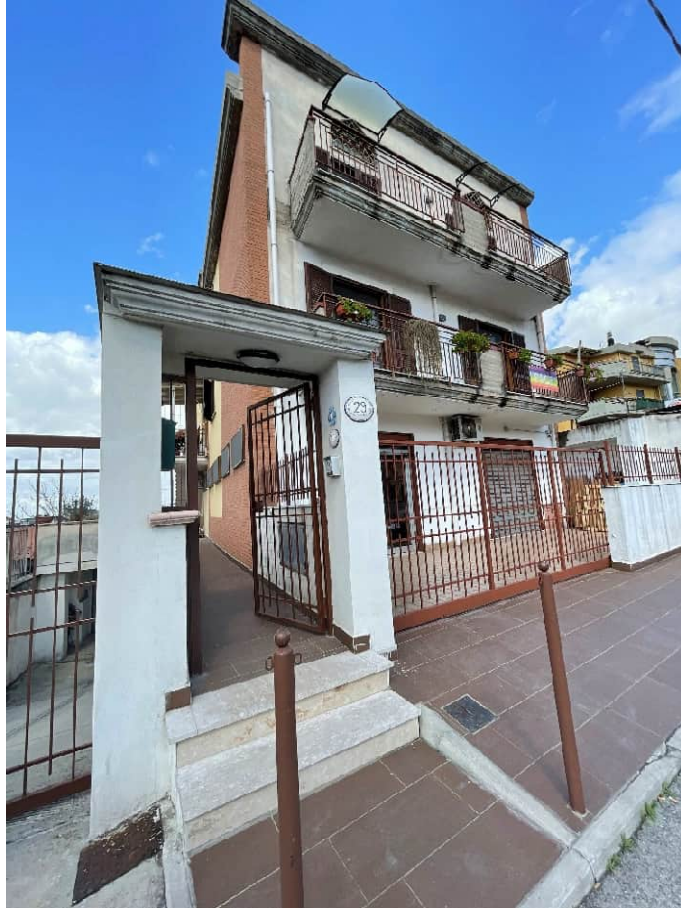
Foto 1 – Vista esterna fabbricato civico n. 29 di Via Santa Lucia
