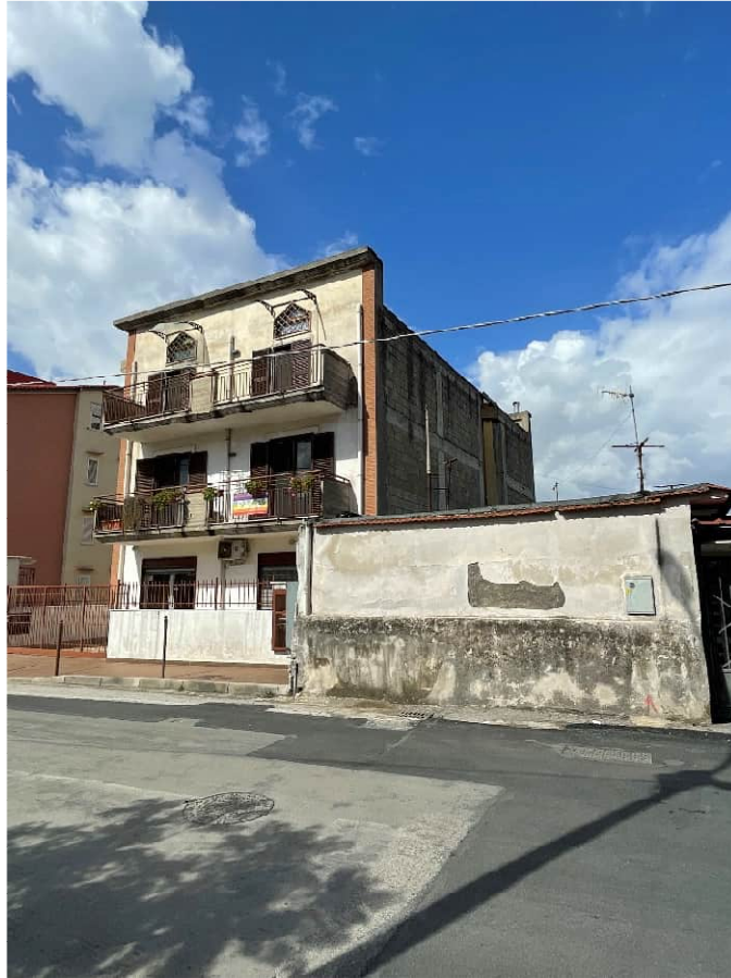
Foto 3 – Vista esterna fabbricato civico n. 29 di Via Santa Lucia
