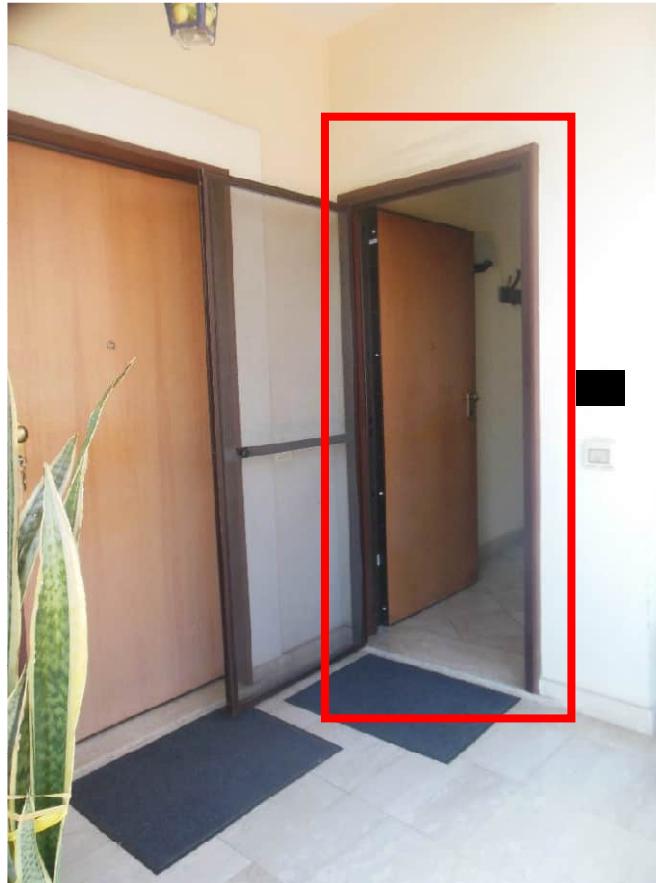
Foto 9 – Vista esterna piano primo: porta di ingresso all'Unità n. 1
