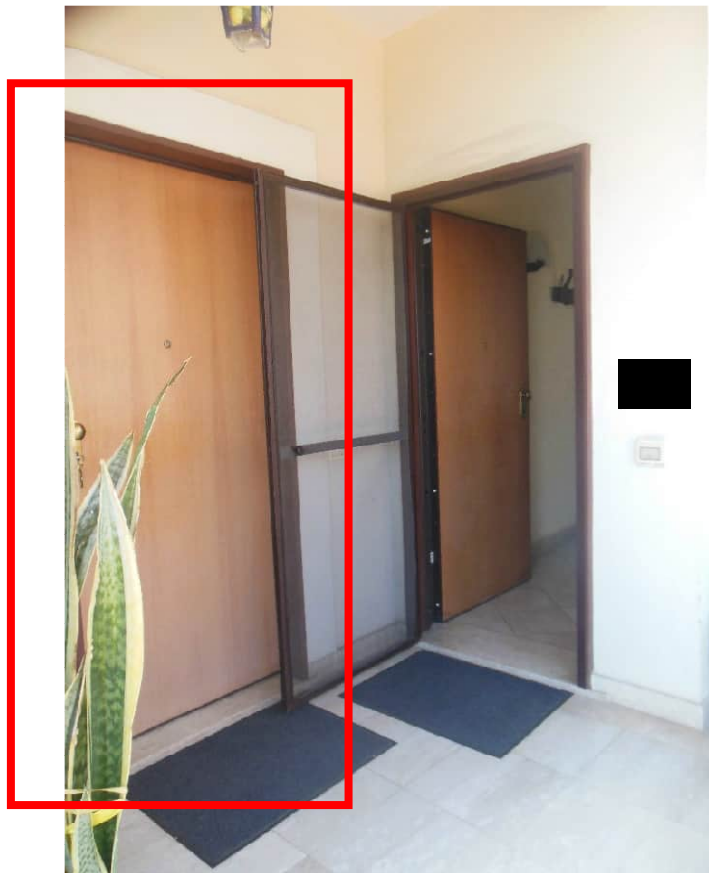
Foto 21 - piano primo Unità n. 2: porta di ingresso
