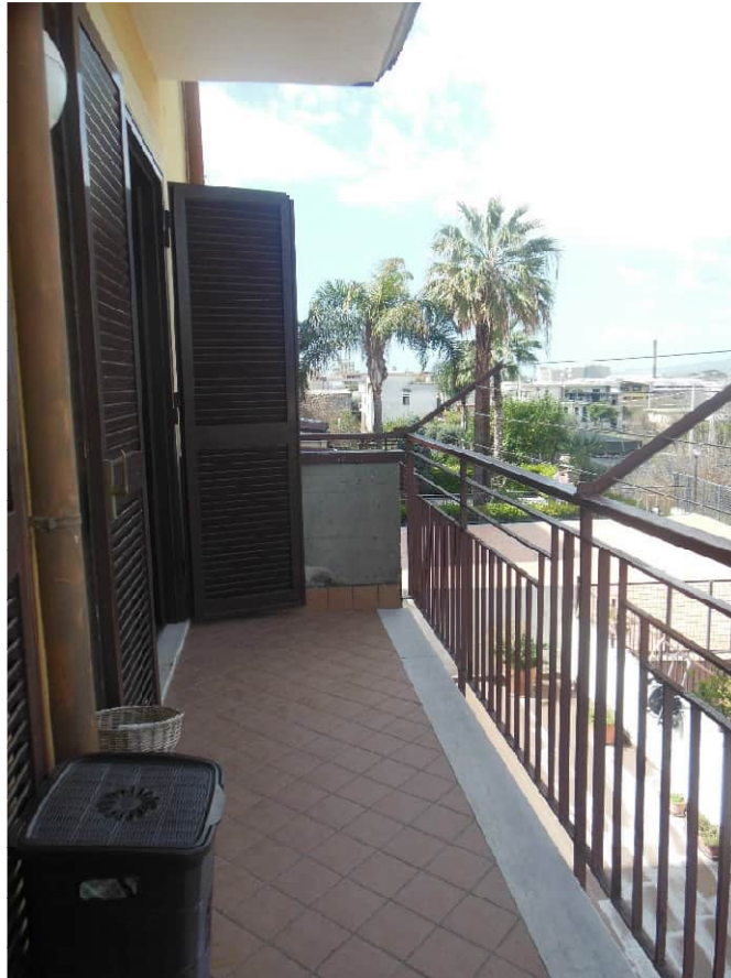
Foto 29 - piano primo Unità n. 2: balcone
