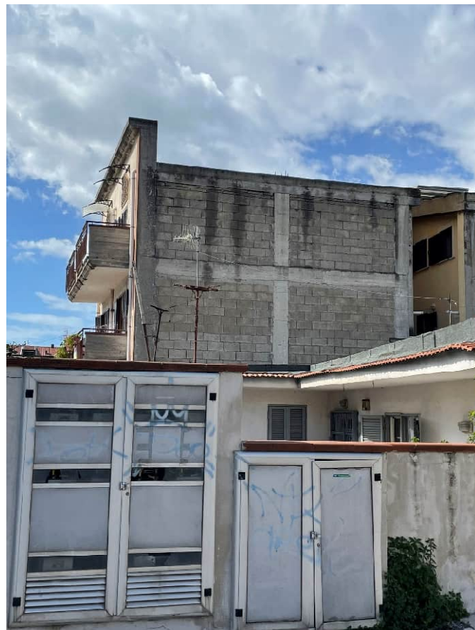
Foto 4 – Vista esterna fabbricato civico n. 29 di Via Santa Lucia: prospetto est
