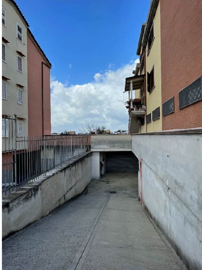
Foto 5 - Vista esterna: rampa di accesso al piano seminterrato non oggetto di pignoramento
