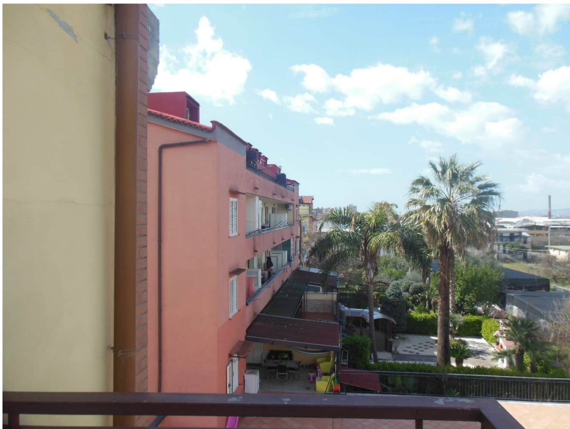
Foto 58 - piano secondo Unità n. 2: vista esterna dal balcone 3
