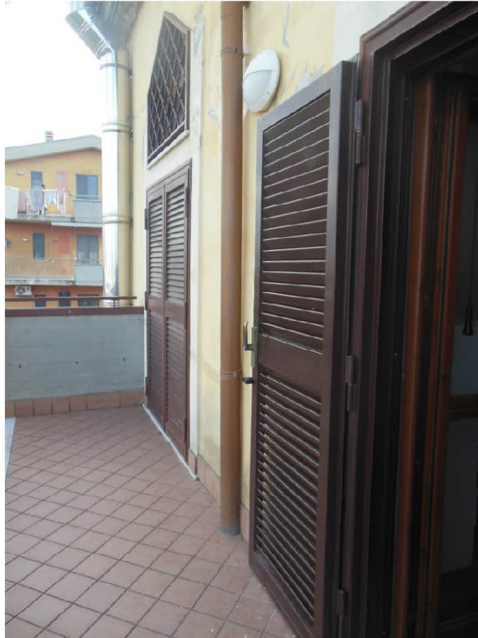
Foto 49 - piano secondo Unità n. 2: balcone 4
