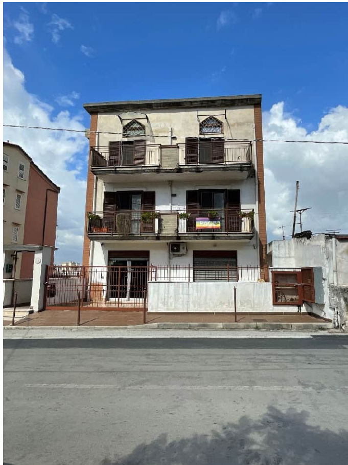
Foto 2 – Vista esterna fabbricato civico n. 29 di Via Santa Lucia
