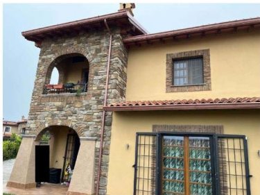
Foto 6. Facciata zona di ingresso
