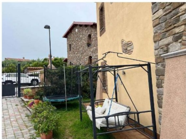
Foto 7. Prospetto laterale e zona corrispondente al posto auto
