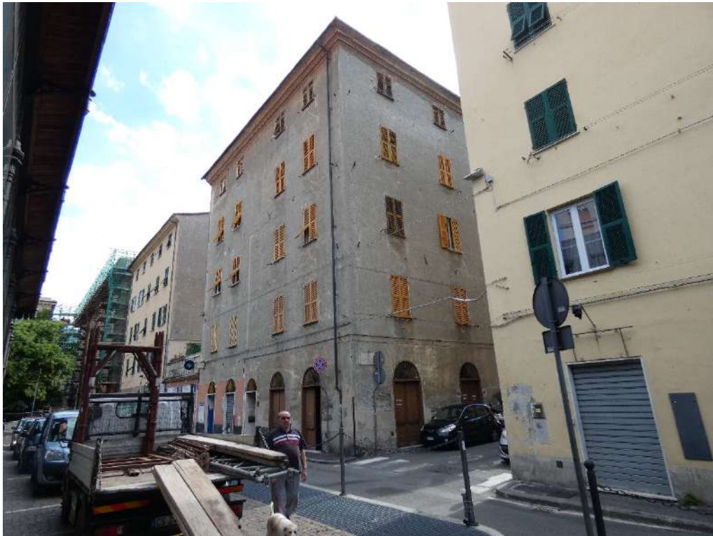
Foto n°33 - vista generale del fabbricato Via Carlo Goldoni civ. 8
