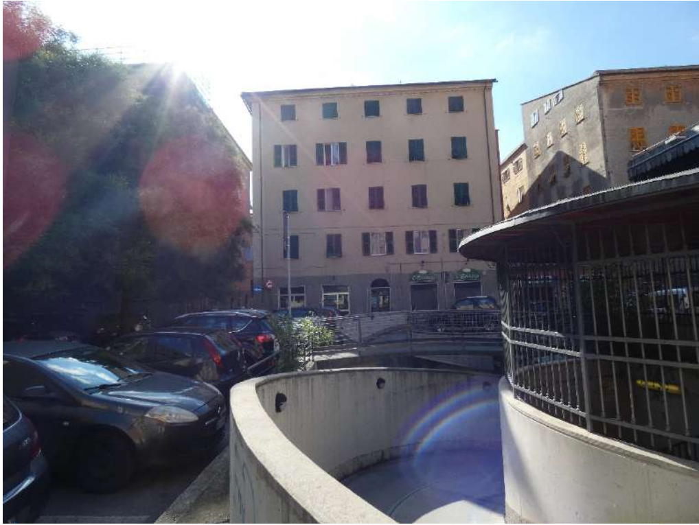
Foto n°13 - vista generale del fabbricato Via Carlo Goldoni civ. 6
