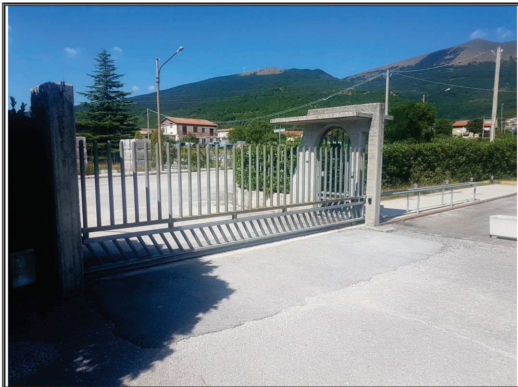
Foto n. 3 Vista del cancello carrabile.
