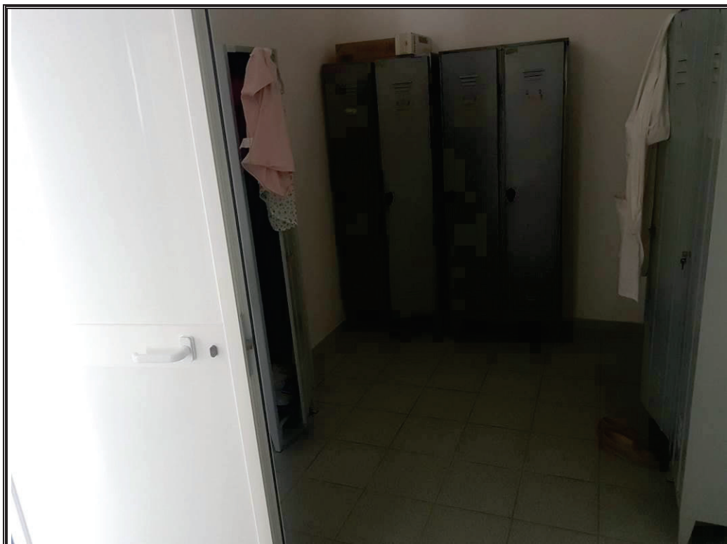
Foto n. 18 Locale del piano terra adibito a spogliatoio del personale
