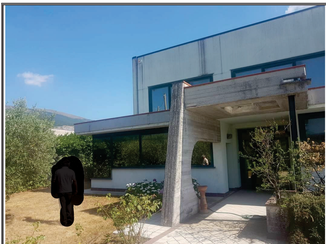
Foto n. 4 Vista esterna del fabbricato.
