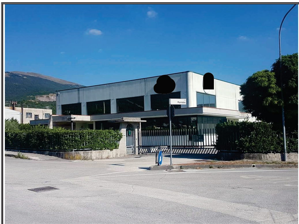
Foto n. 1 Vista esterna del complesso.
