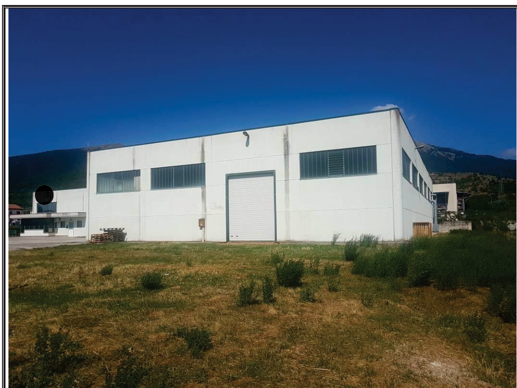
Foto n. 8 Vista di parte della corte non asfaltata e di parte del capannone.
