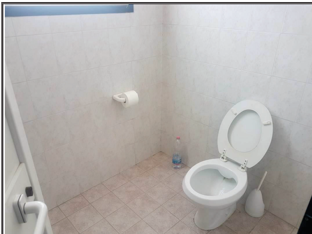
Foto n. 16 Servizio igienico al piano terra.
