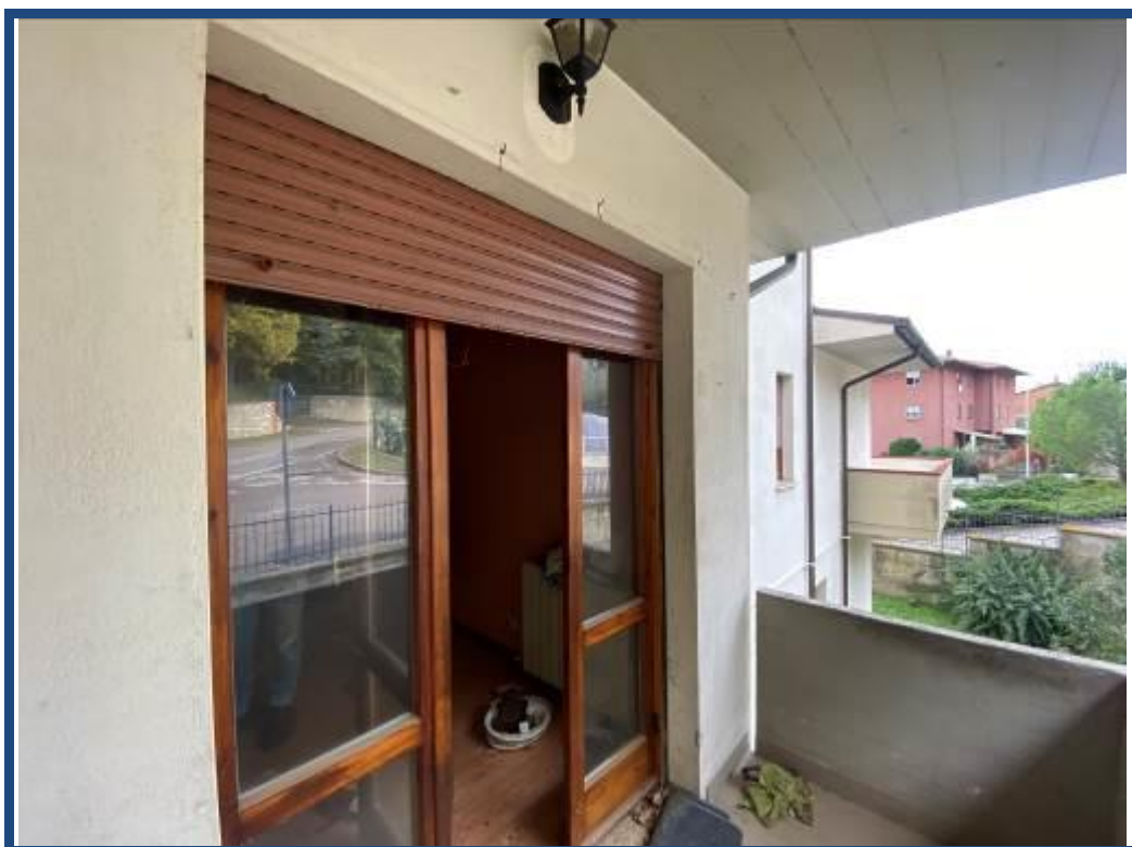
Foto 18 – Vista della terrazza.
