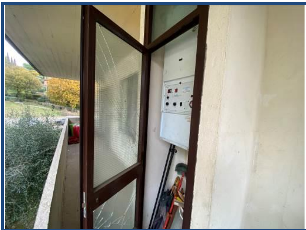
Foto 16 – Vista della terrazza.
