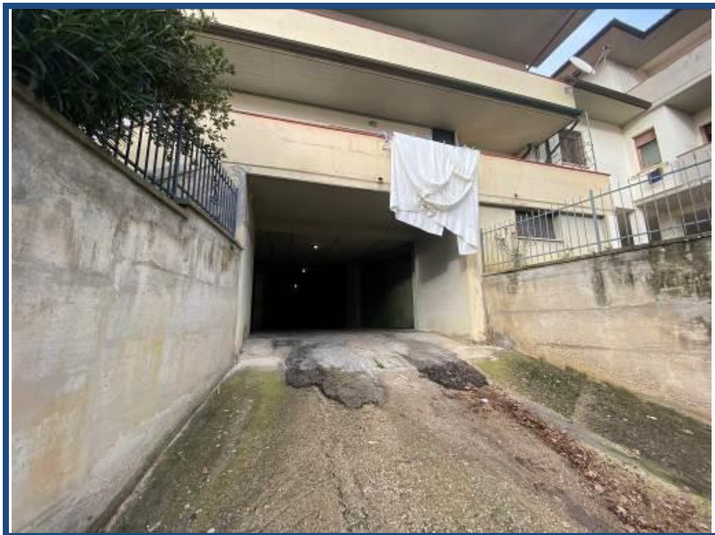
Foto 19 – Vista esterna della rampa di accesso ai garage.
