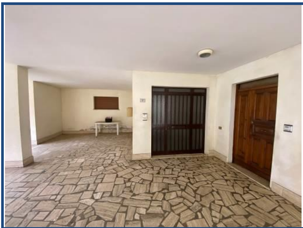
Foto 5 – Vista esterna del portone di ingresso alla palazzina.
