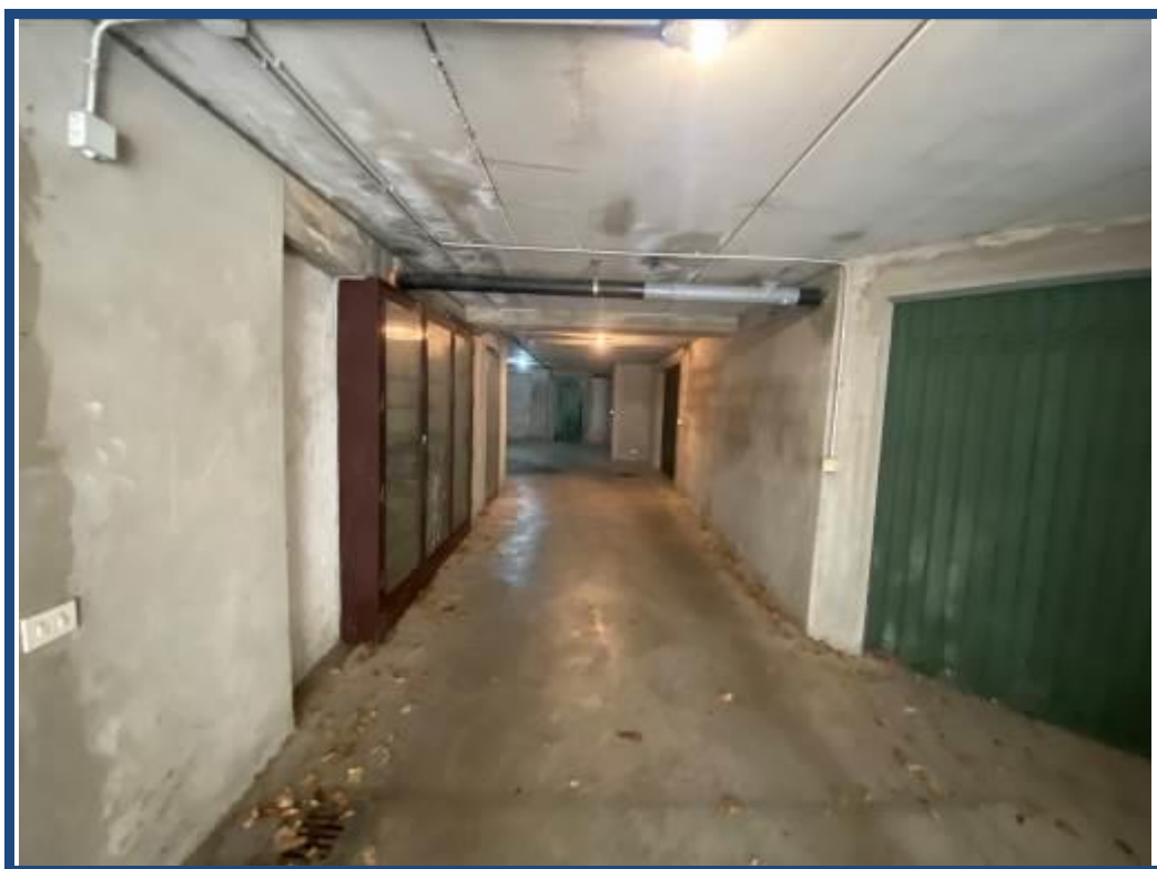
Foto 20 – Vista del piano 1S destinato a garage.
