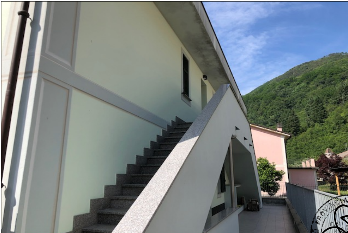
FOTO N° 4: Particolare accesso esterno al piano primo.
