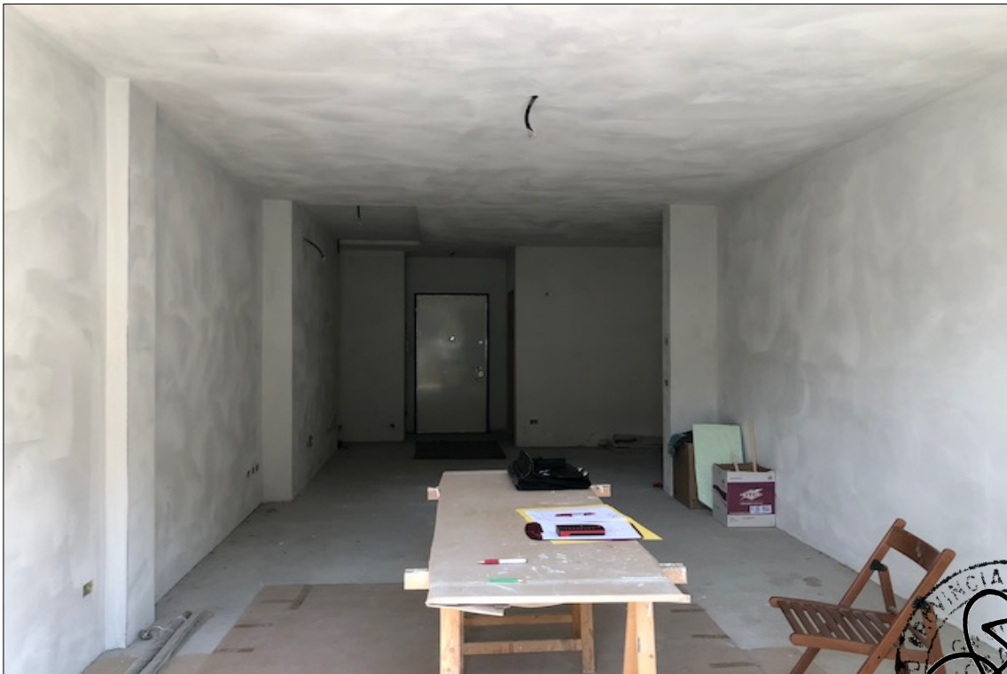
FOTO N° 8: Particolare di cui alla foto precedente.
