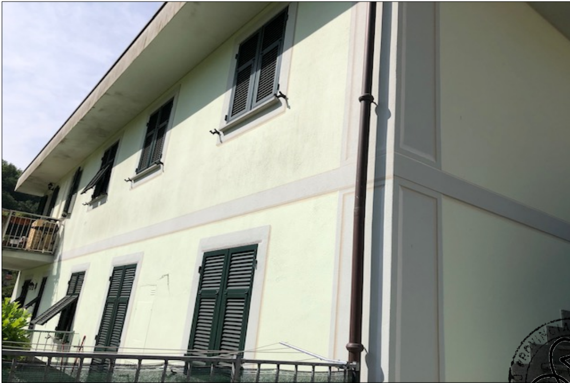
FOTO N° 3: Vista generale immobile Seconda traversa di Via Mario Ginocchio
