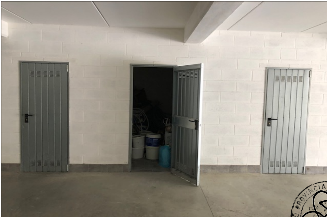
FOTO N° 20: Particolare accesso cantina.
