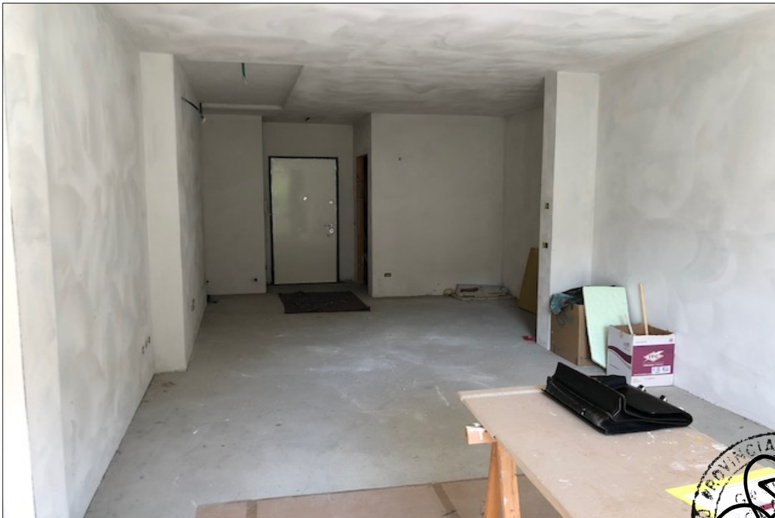
FOTO N° 10: Particolare di cui alla foto precedente.
