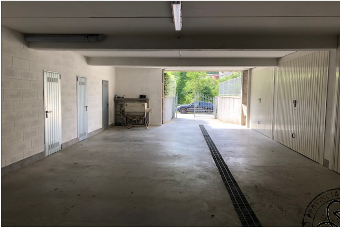
FOTO N° 19: Vista area comune di accesso piano fondi.
