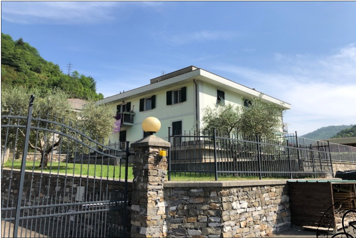
FOTO N° 1: Vista generale immobile Seconda traversa di Via Mario Ginocchio
