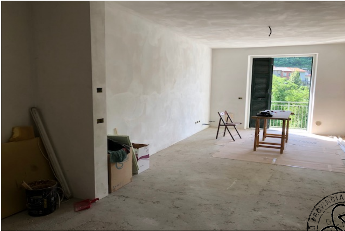
FOTO N° 7: Vista interna dei locali appartamento int. 5.
