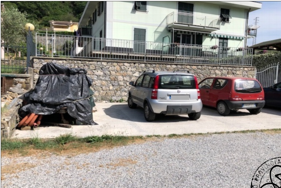
FOTO N° 24: Particolare di cui alla foto precedente.
