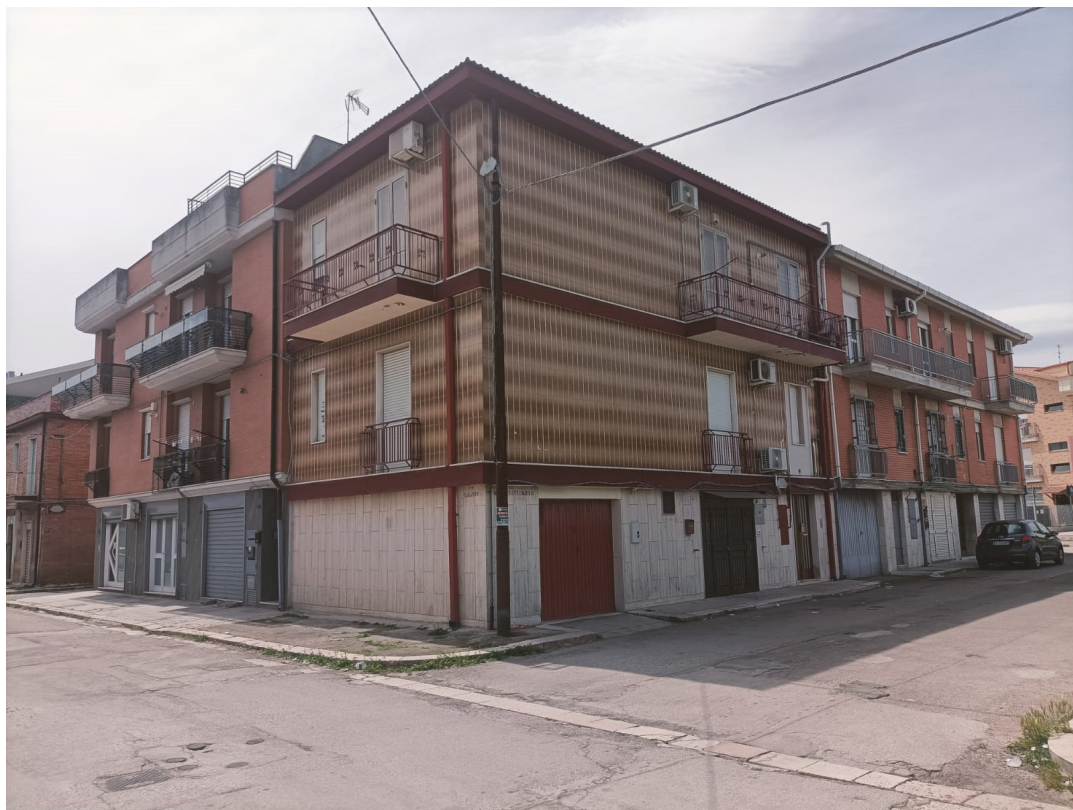
Vista immobile oggetto di causa (piano 1)
