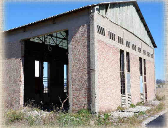
Sub.22 – Locale Diesel (previsto in demolizione)
