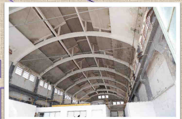
Sub.27 - Magazzino Motori e Pompe
