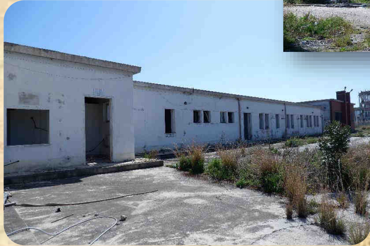
sub.37 - Uffici e Magazzino Prodotti Finiti
