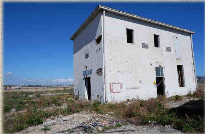
Sub.21 – Cabina elettrica (prevista in demolizione)
