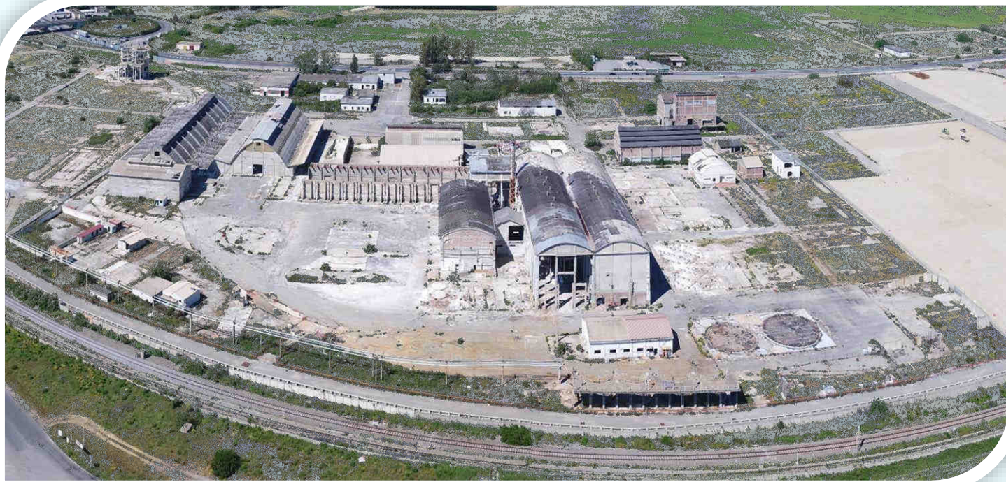
Vista aerea ad Est del sito
