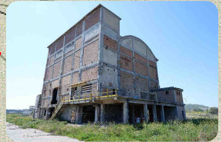
Sub.28 – ex Centrale Termica (prevista in demolizione)
