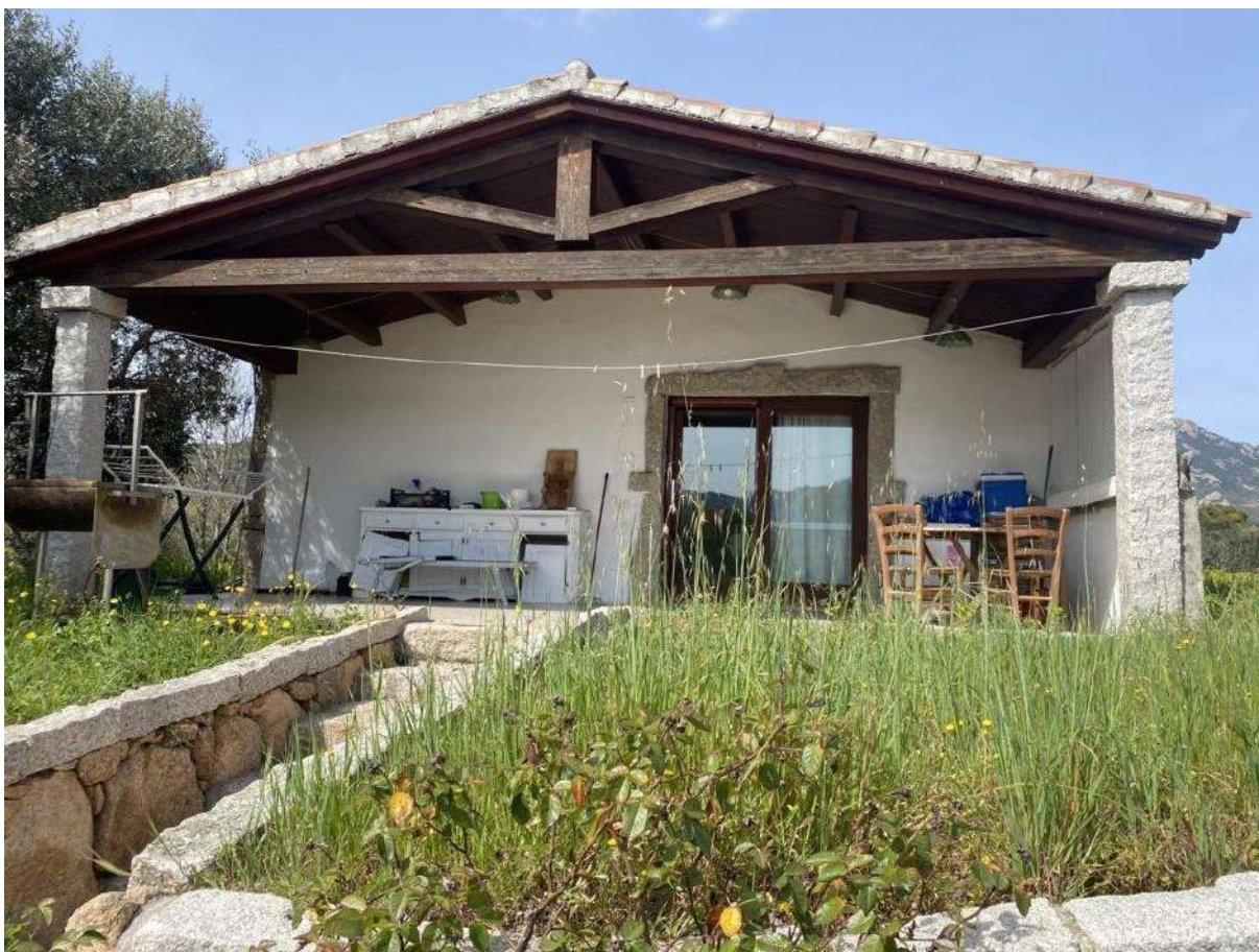
FOTO 2 – VERANDA INGRESSO PIANO TERRA
