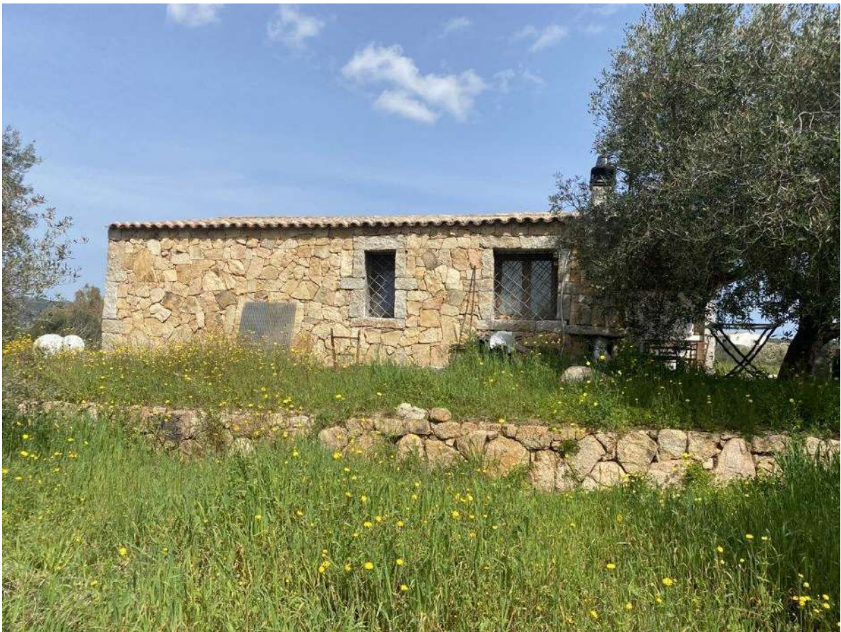
FOTO 5 – VISTA PIANO TERRA
