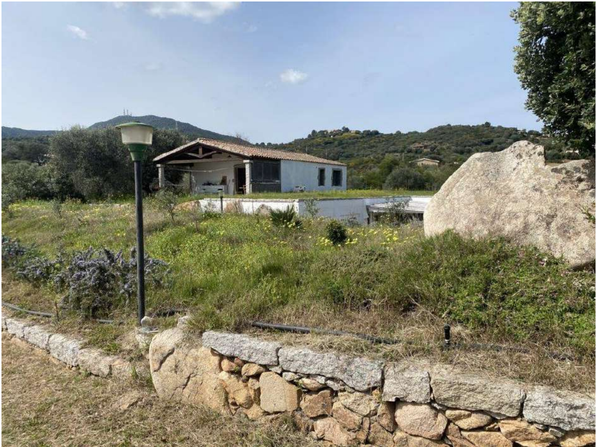
FOTO 3 – VISTA PIANO TERRA
