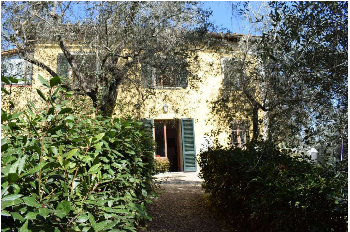
Foto n. 11_ Sopralluogo del 01/04/2019 La facciata dell'edificio part.Illa 133 per chi arriva dal nc 54
