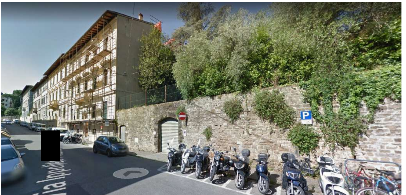
Foto n. 2_ Tratta da Google Maps Via Ippolito Pindemonte con l'alto muro in pietra che delimita la proprietà oggetto della procedura e gli accessi all'autorimessa nc 20/R e alla proprietà nc 54
