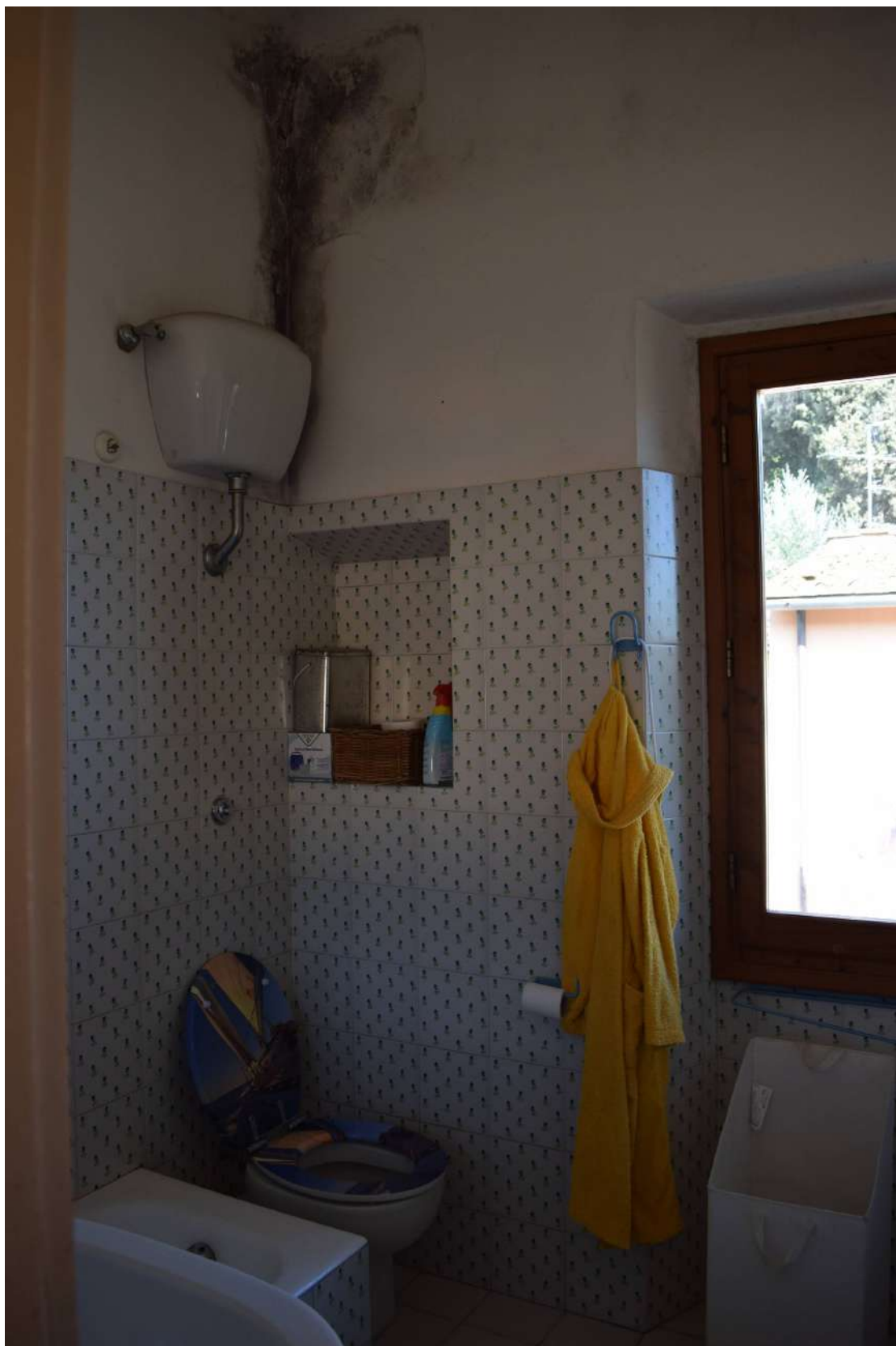
Foto n. 27_ Sopralluogo del 01/04/2019 Edificio part.IIa 133: piano primo, bagno accessibile da disimpegno
