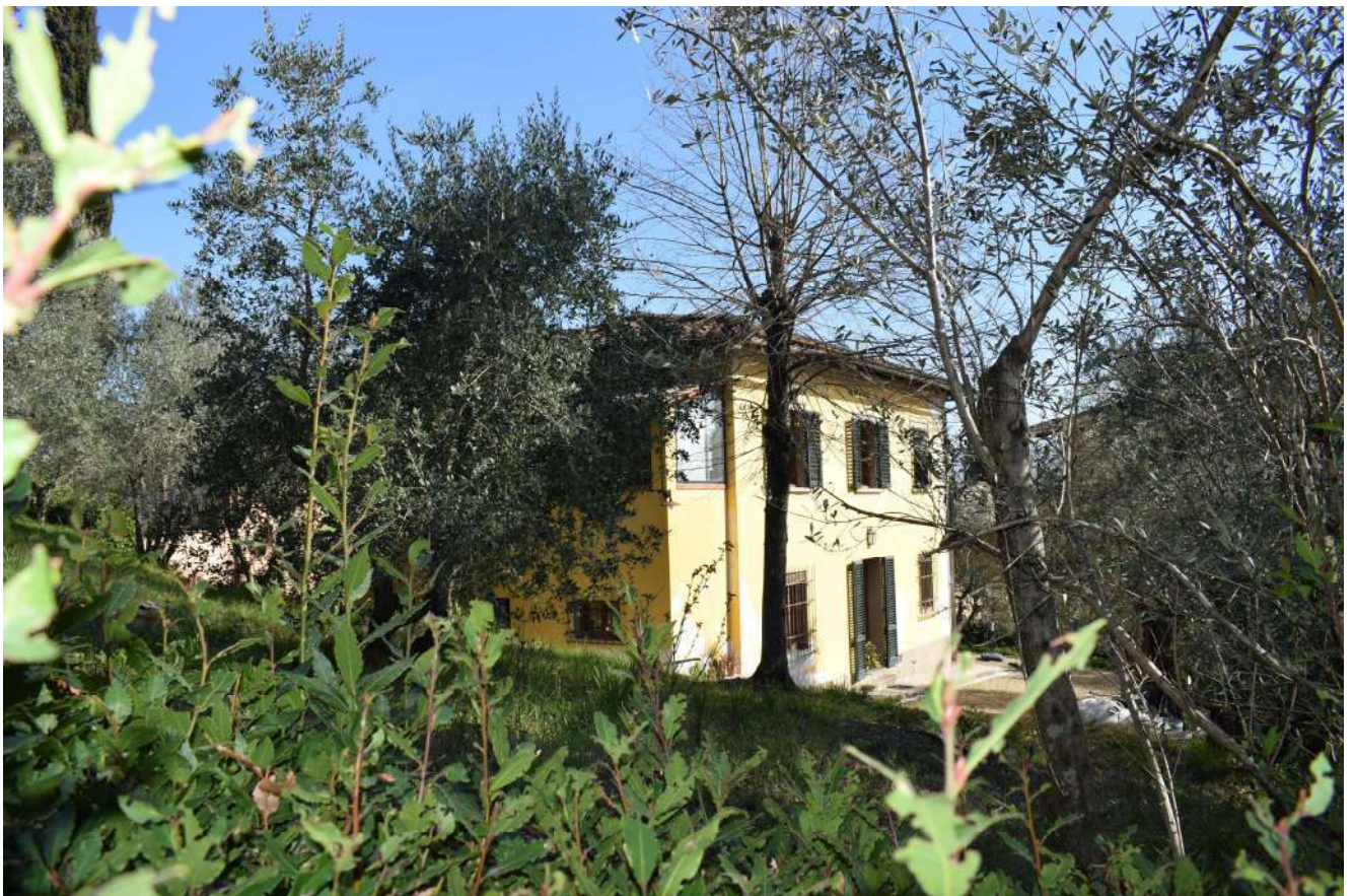
Foto n. 12_ Sopralluogo del 01/04/2019 Dal parco/giardino vista sull'edificio part.Illa 133
