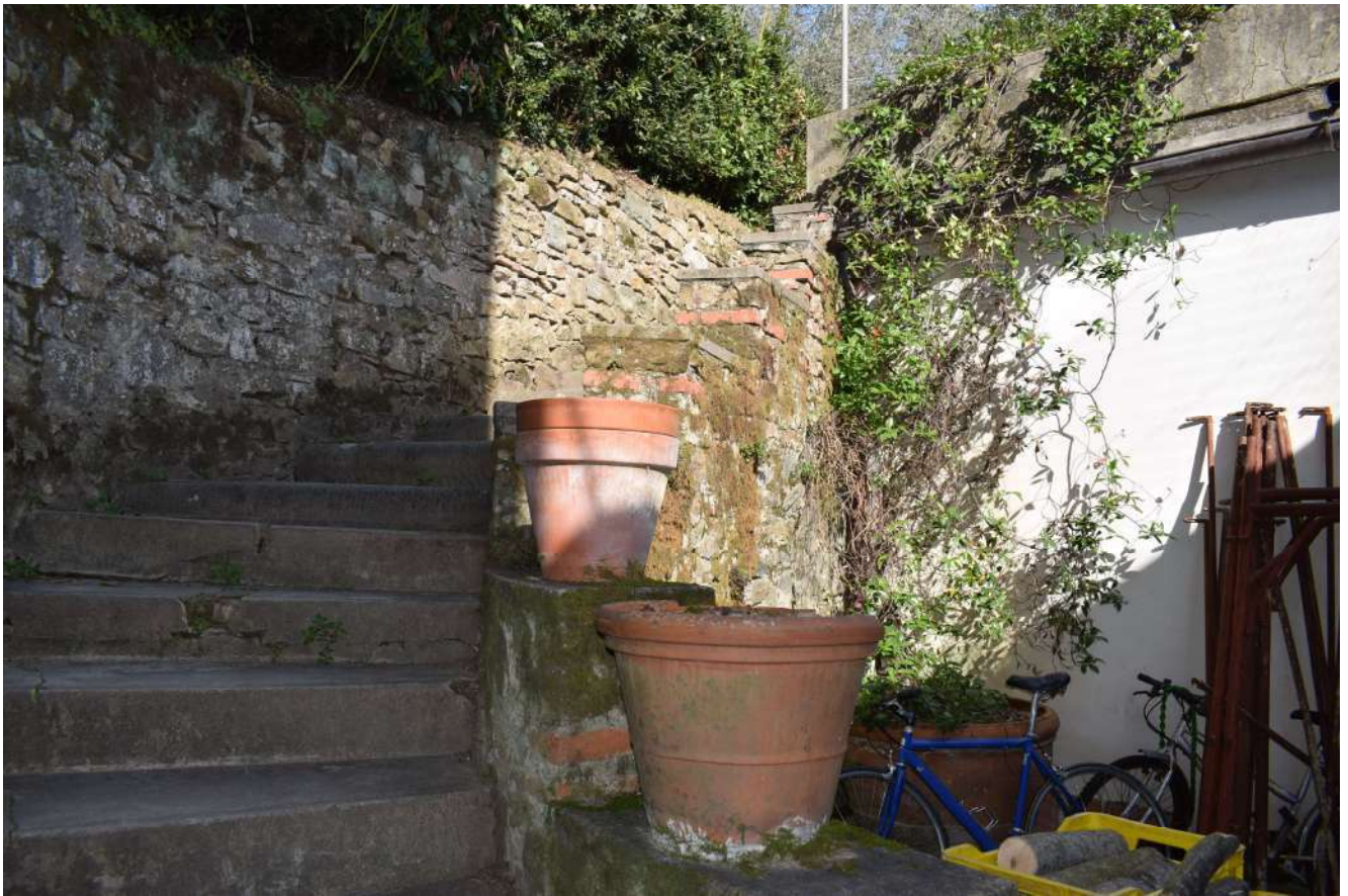
Foto n. 8_ Sopralluogo del 01/04/2019 La scala a lato dell'autorimessa che conduce all'edificio part.Ila 133
