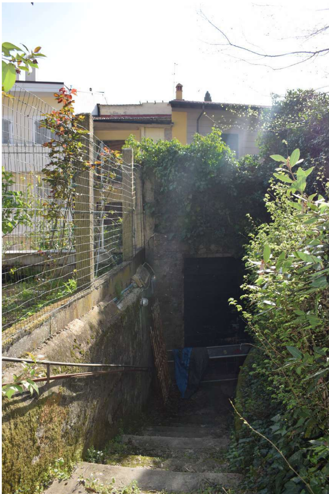
Foto n. 42_Sopralluogo del 01/04/2019 L'accesso numero civico 50 al confine della proprietà
