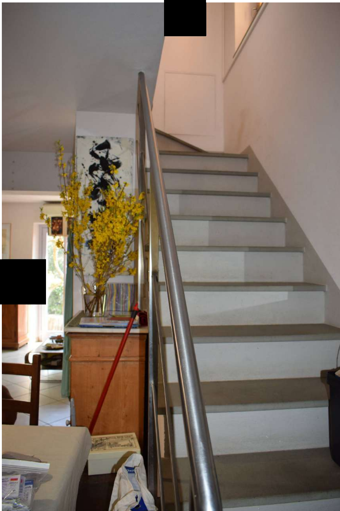
Foto n. 35_Sopralluogo del 01/04/2019 Edificio part.lla 132 sub 1: scala per accesso al piano primo
