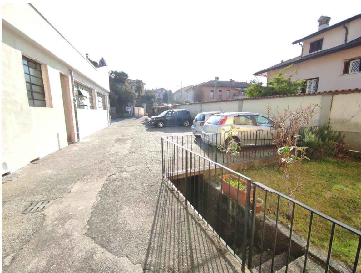
Area esterna part. 1768 gravata da servitù di sosta di autoveicoli e scala accesso alla centrale termica part. 1768 sub. 701
