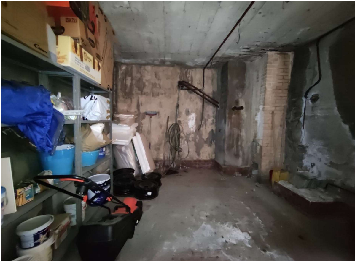
Vano ex centrale termica part. 1768 sub. 701
