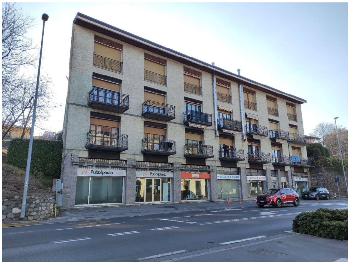
Vista fabbricato da Via Roma
