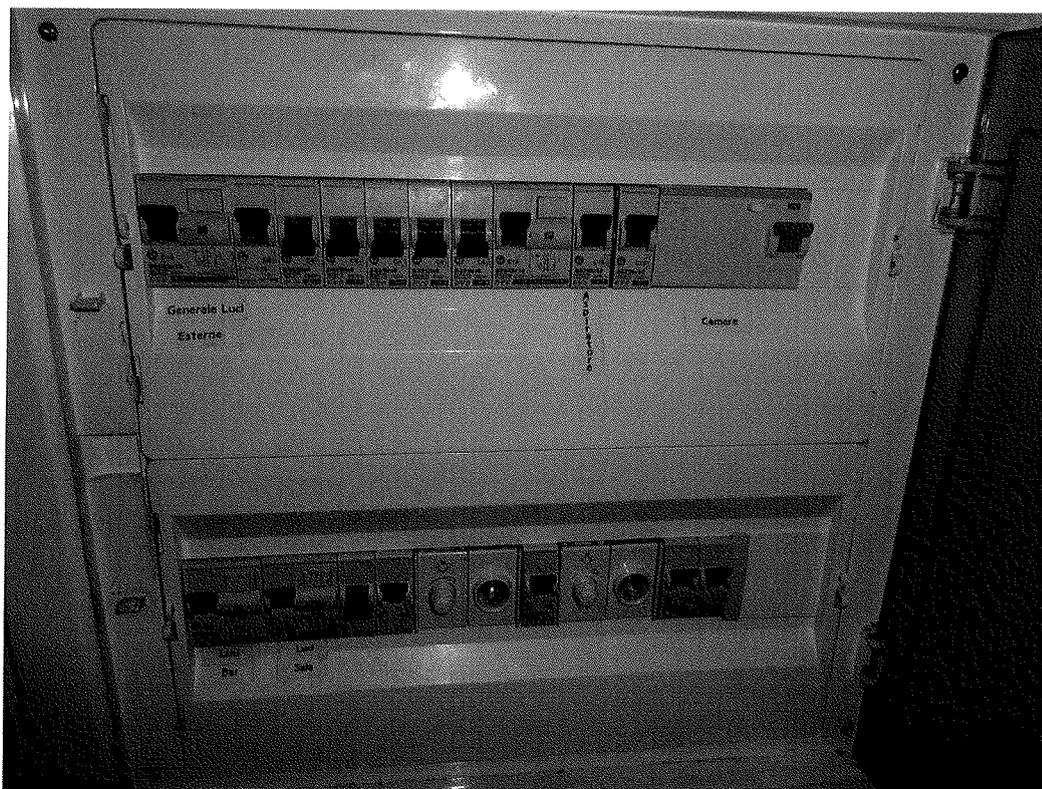
Trattasi di quadro elettrico ad incasso con doppia carpenteria e dotato di sportelli di chiusura.
