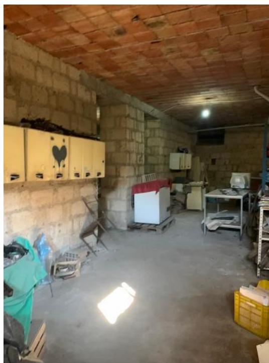
Foto n. 3 – Particolare locale deposito
