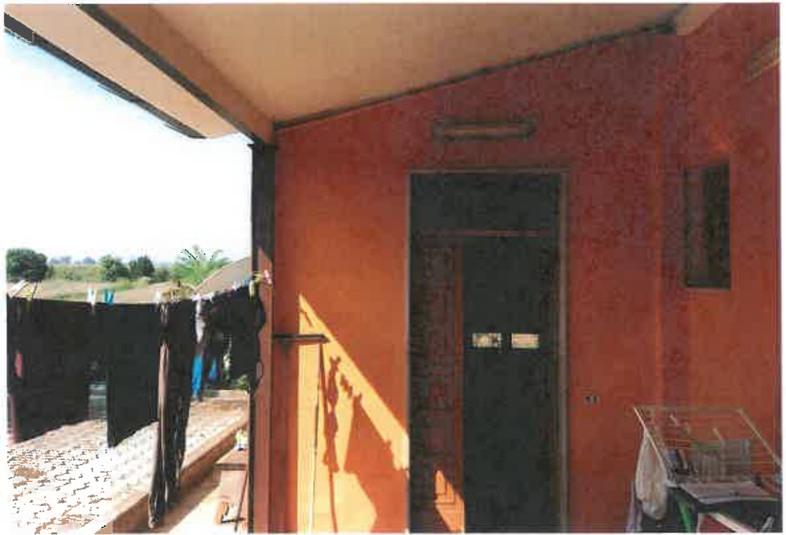
PONTINIA - INGRESSO CUCINA
