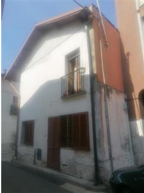
Prospetto su via Mazzini
