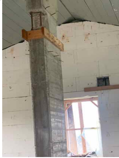
part. colonna e muro perimetrale
