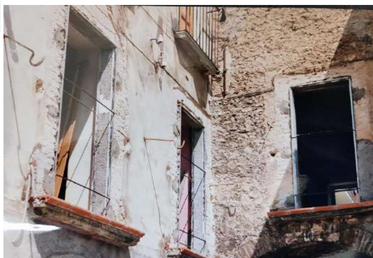
Facciata Sud e Ovest
