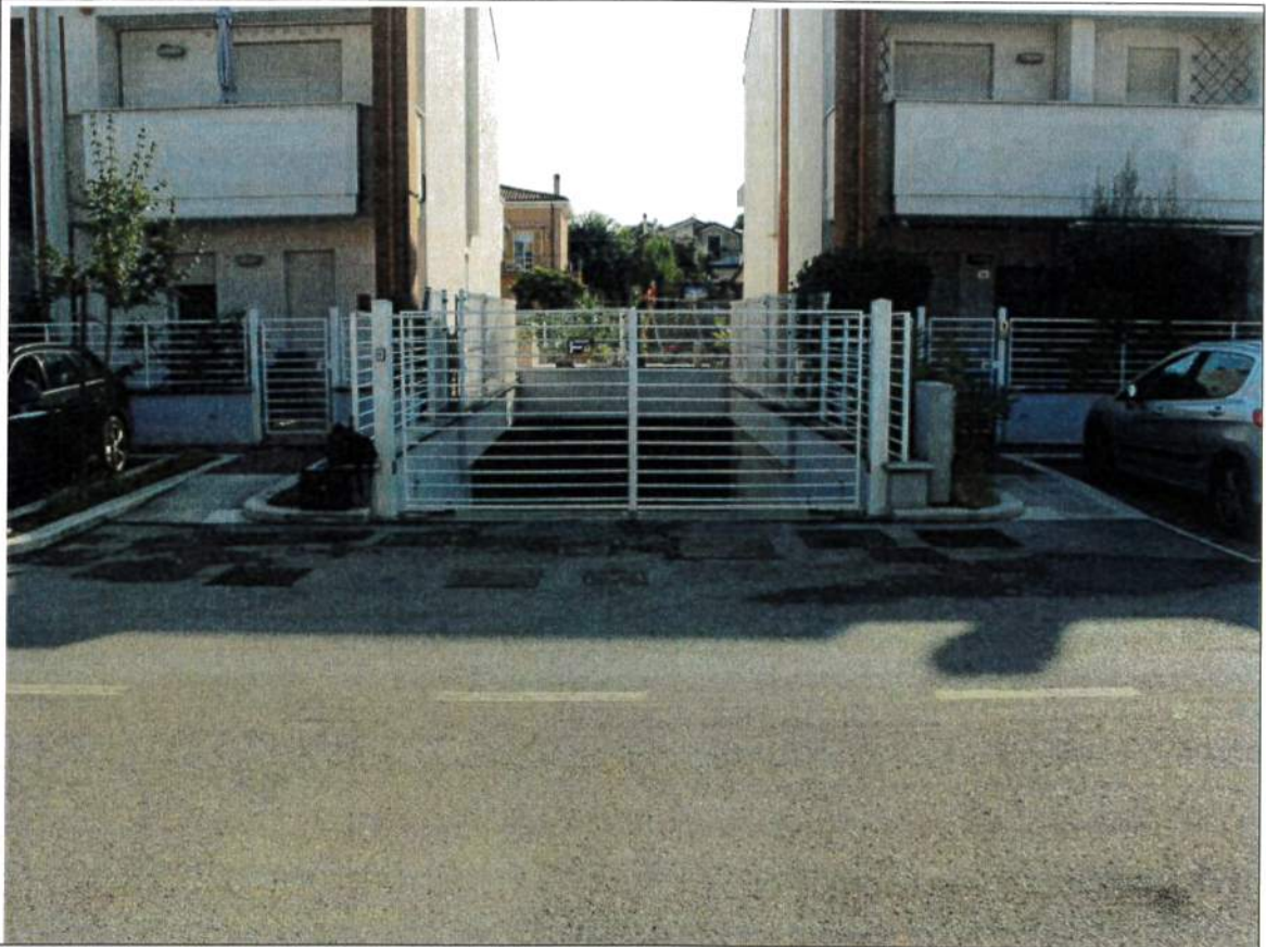
- IMMAGINE N° 3 - (accesso alla rampa carrabile)
