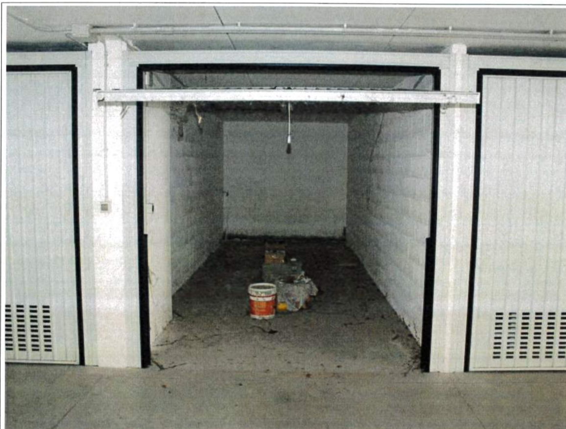
- IMMAGINE N° 5 - (autorimessa - Subalterno n° 2 - piano interrato)
