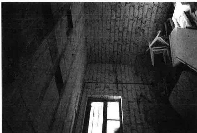
Edificio più recentemente
