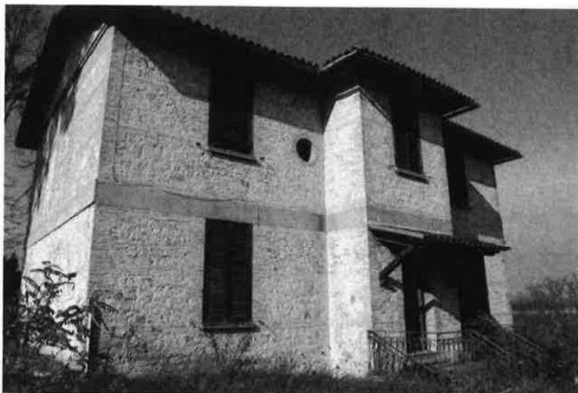
Edificio principale – prospetto ingresso
