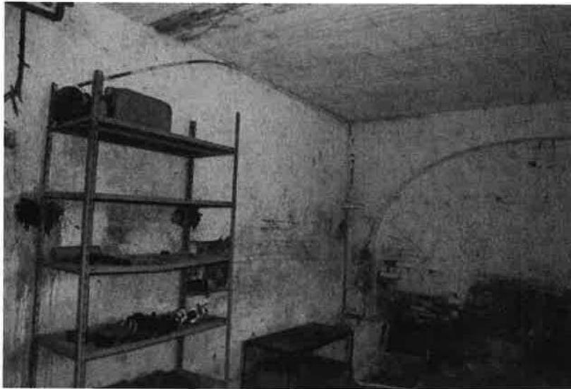
Magazzino al piano terra
