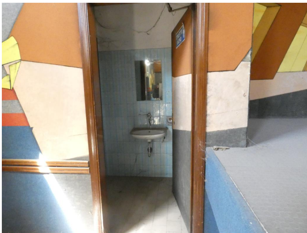
Presa fotografica 36 – Vista Interna: Ingresso W.C.
