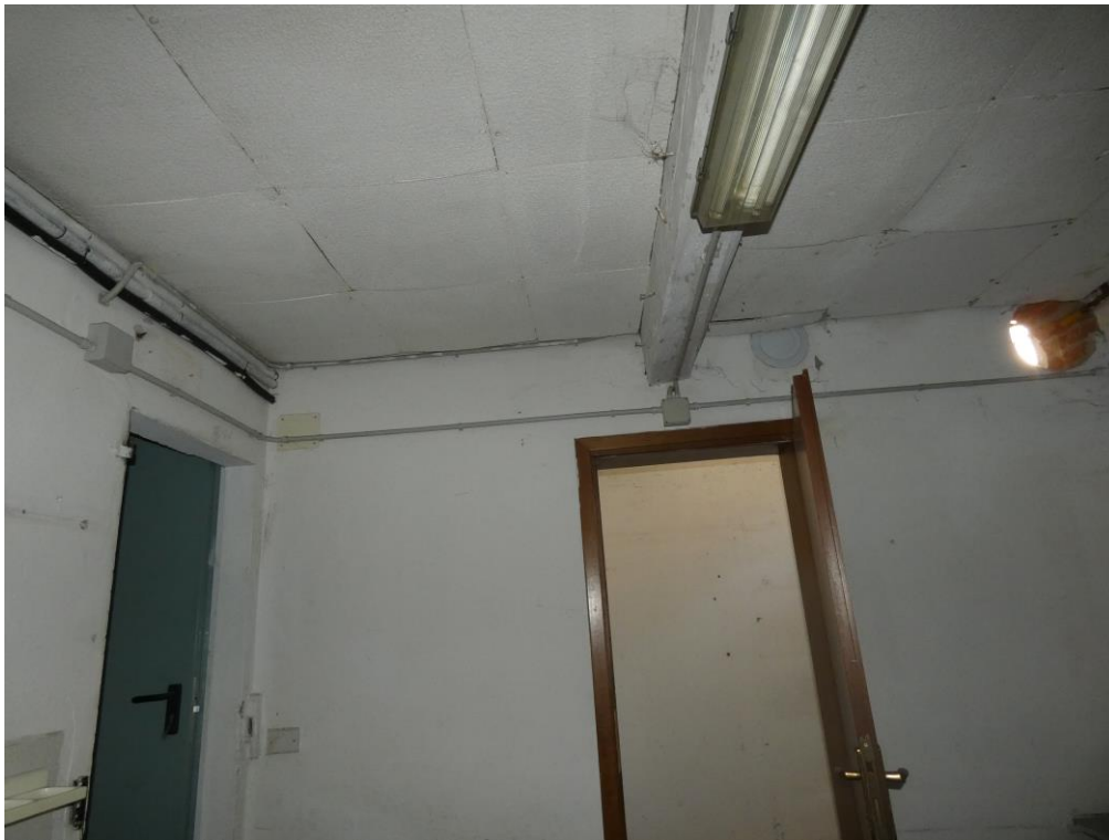
Presafotografica 19 – Vista Interna: Intradosso controsoffitto del solaio del piano primo
