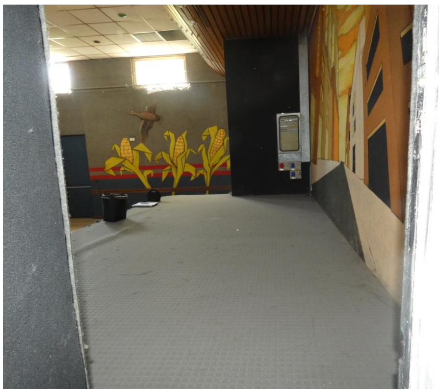
Presenza fotografica 54 – Vista Interna della sala circolo: Ingresso al palco dal ripostiglio
