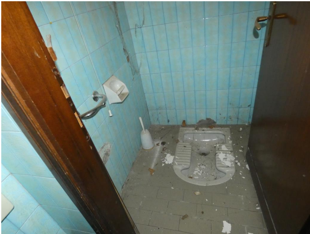
Presenza fotografica 41 – Vista Interna: W.C.
