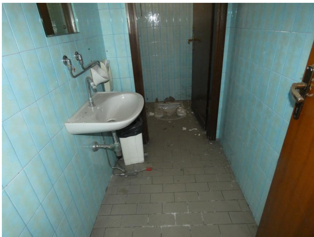
Presa fotografica 40 – Vista Interna: Ingresso antibagno e W.C.
