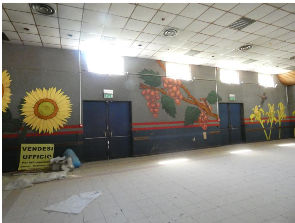
Presafotografica 31 – Vista Interna della sala circolo: Uscite di sicurezza
