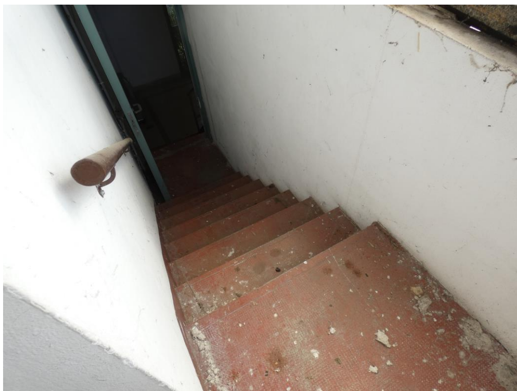
Presafotografica 75 – Vista Interna del vano scala dal Piano Primo
