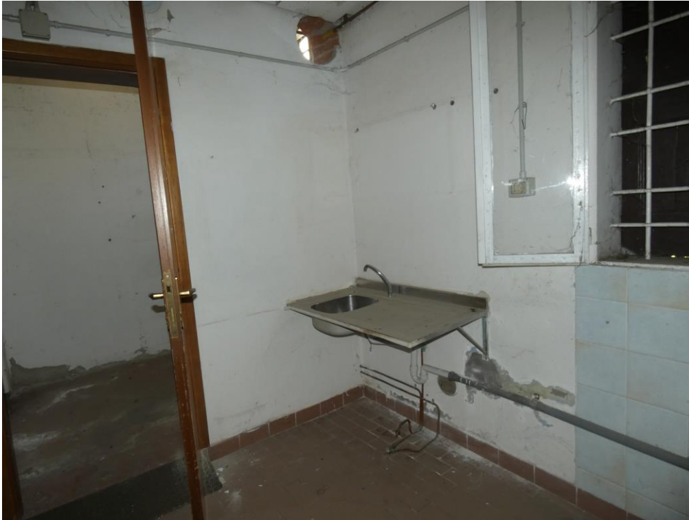
Presenza fotografica 17 – Vista Interna: Cucina verso Nord
