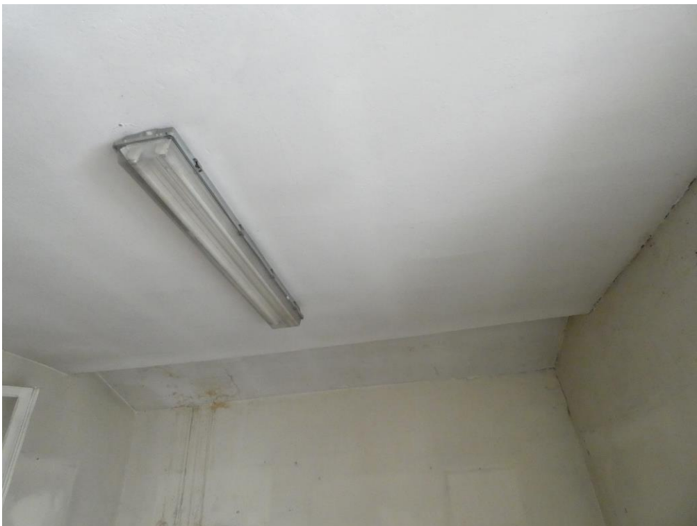
Presenza fotografica 67 - Vista Interna Ufficio: Diverse quote dell'intradosso del solaio di copertura
