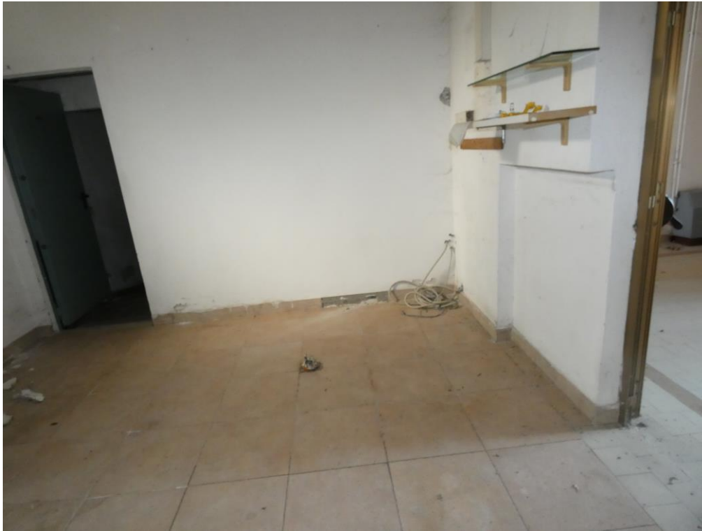
Presa fotografica 11 – Vista Interna: Zona bar verso Est
