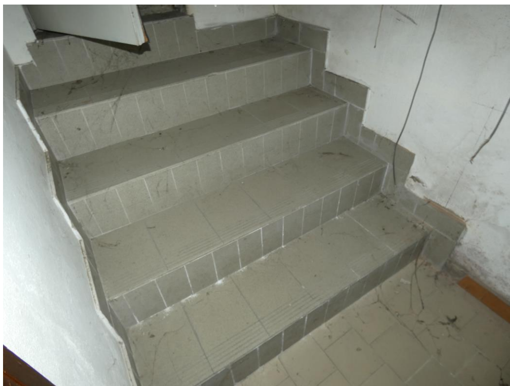
Presa fotografica 45 – Vista Interna ripostiglio: Scale d'accesso al palco
