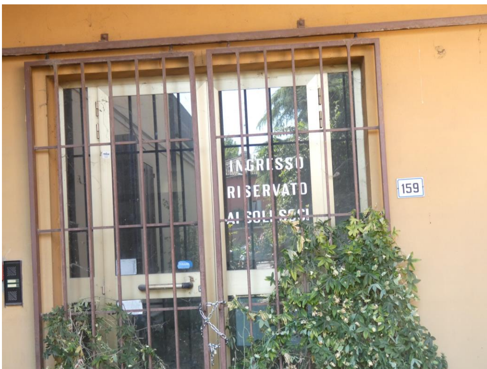
Presa fotografica 02 – Vista Esterna del fabbricato: Ingresso principale
