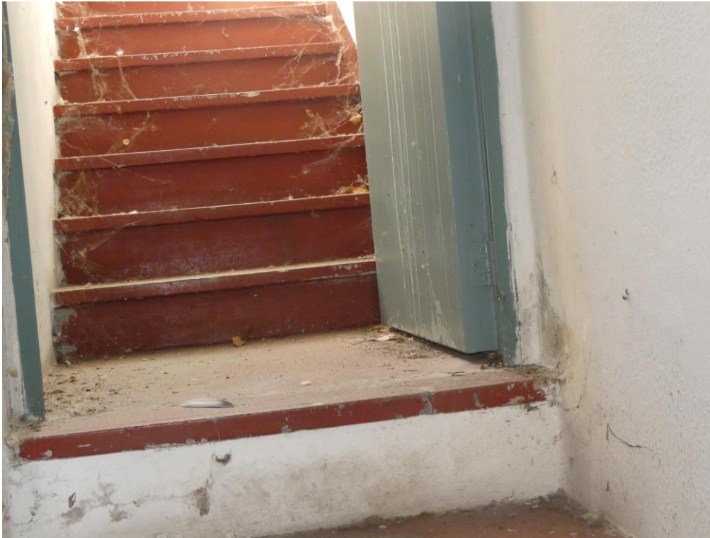
Presenza fotografica 64 – Vista Interna Ingresso: Pianerottolo della scala
