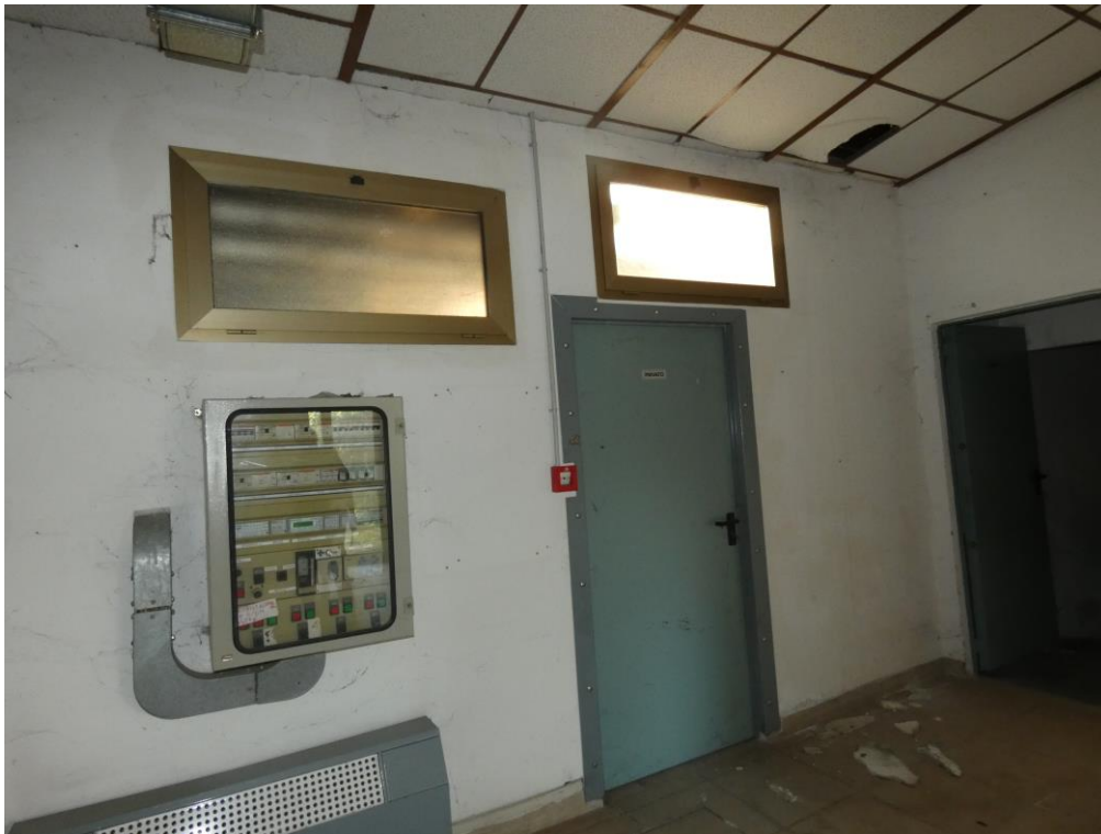
Presa esterna 09 – Vista Interna: Zona bar verso Nord
