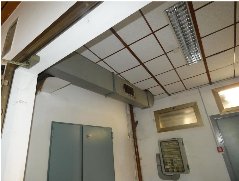
Presa fotografica 08 – Vista Interna: Intradosso controsoffitto del solaio piano primo
