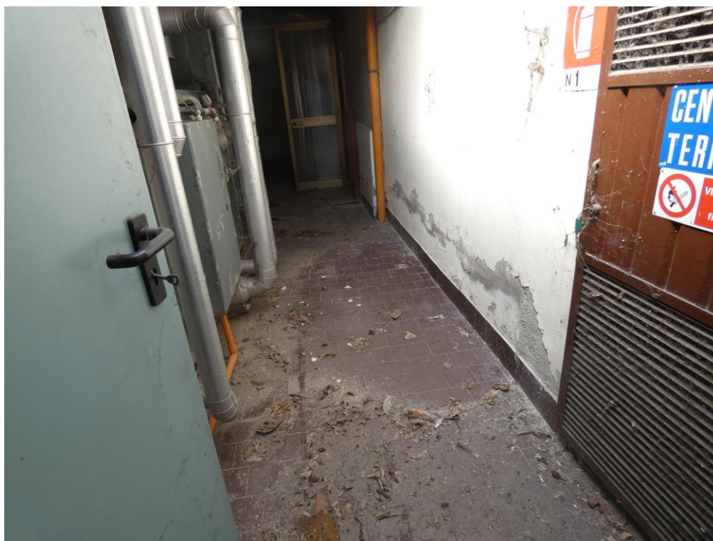
Presenza fotografica 62 – Vista Interna: Magazzino e porta d'ingresso alla centrale termica
