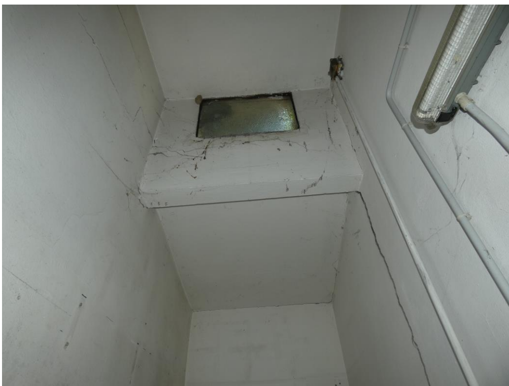
Presa fotografica 49 – Vista Interna ripostiglio: Intradosso del solaio del Piano Primo: i due diversi solai
