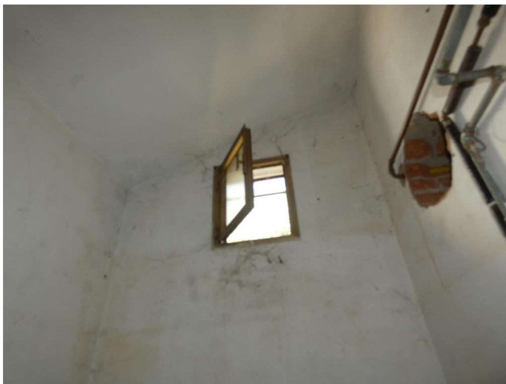
Presenza fotografica 21 – Vista Interna ripostiglio: Finestra
