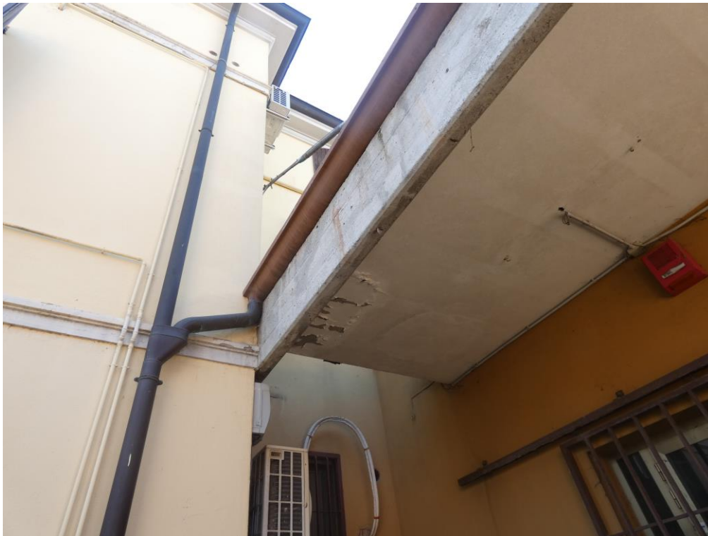
Presa fotografica 03 – Vista Esterna: Veletta di protezione dell'ingresso principale
