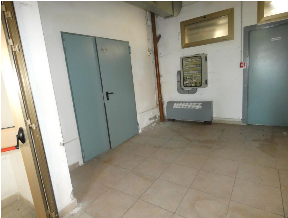
Presa fotografica 07 – Vista Interna: Zona bar verso Nord - Ovest
