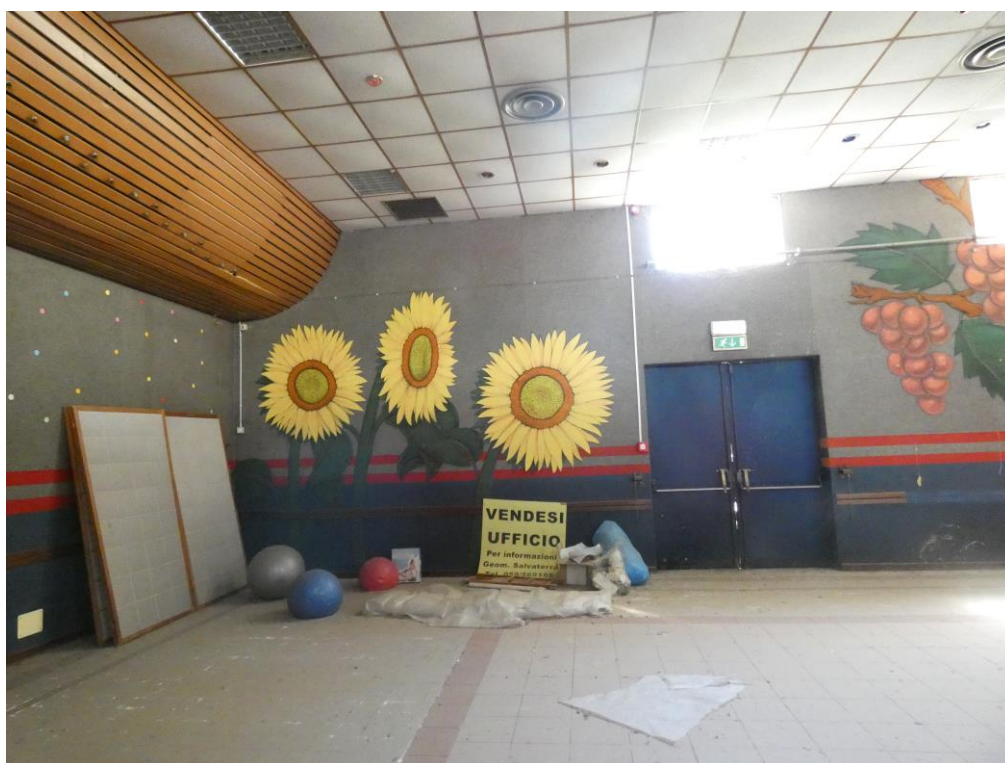
Presenza fotografica 30 – Vista Interna della sala circolo: Uscita di sicurezza
