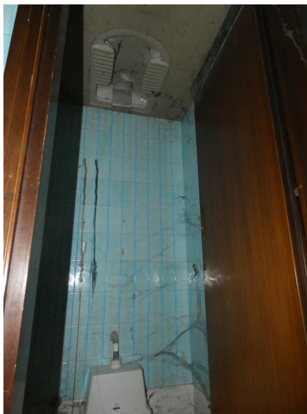
Presenza fotografica 38 – Vista Interna W.C.
