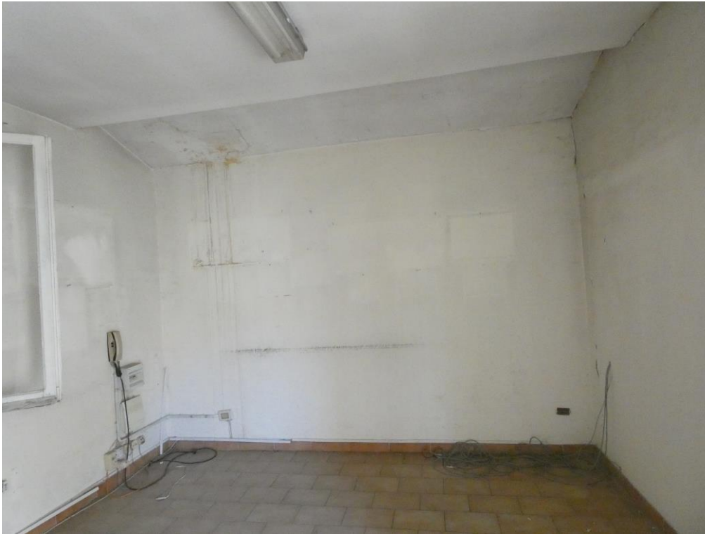
Presenza fotografica 66 – Vista Interna Ufficio: Diverse quote dell'intradosso del solaio di copertura
