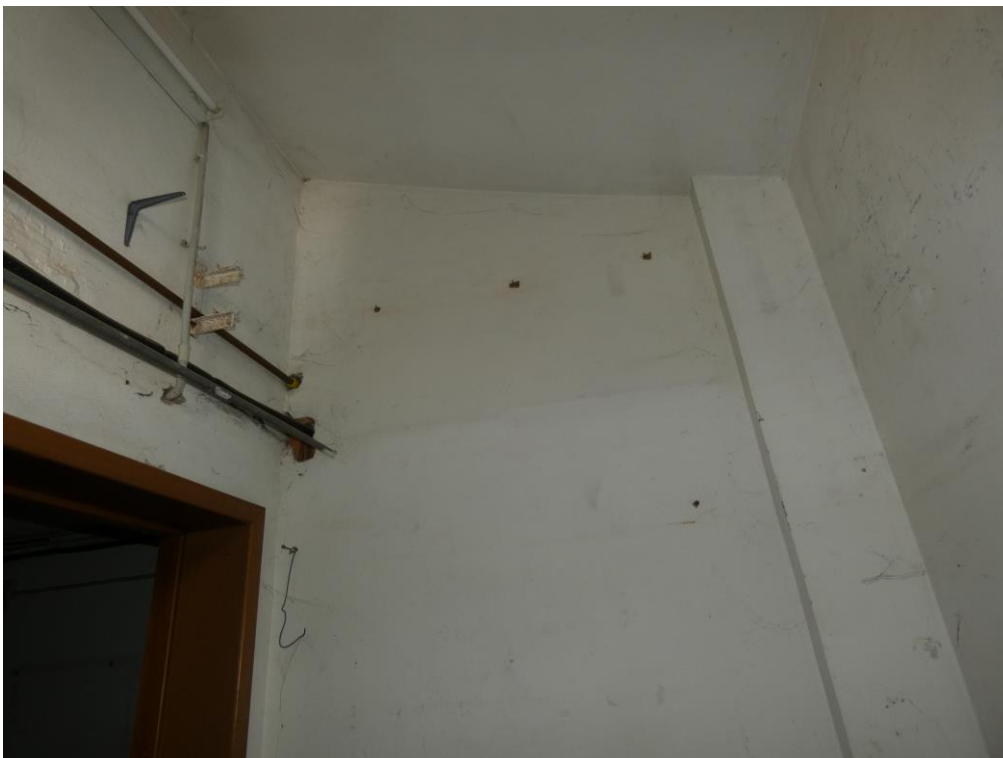
Presenza fotografica 24 – Vista Interna ripostiglio: Intradosso controsoffitto del solaio del piano primo/ pilastro
