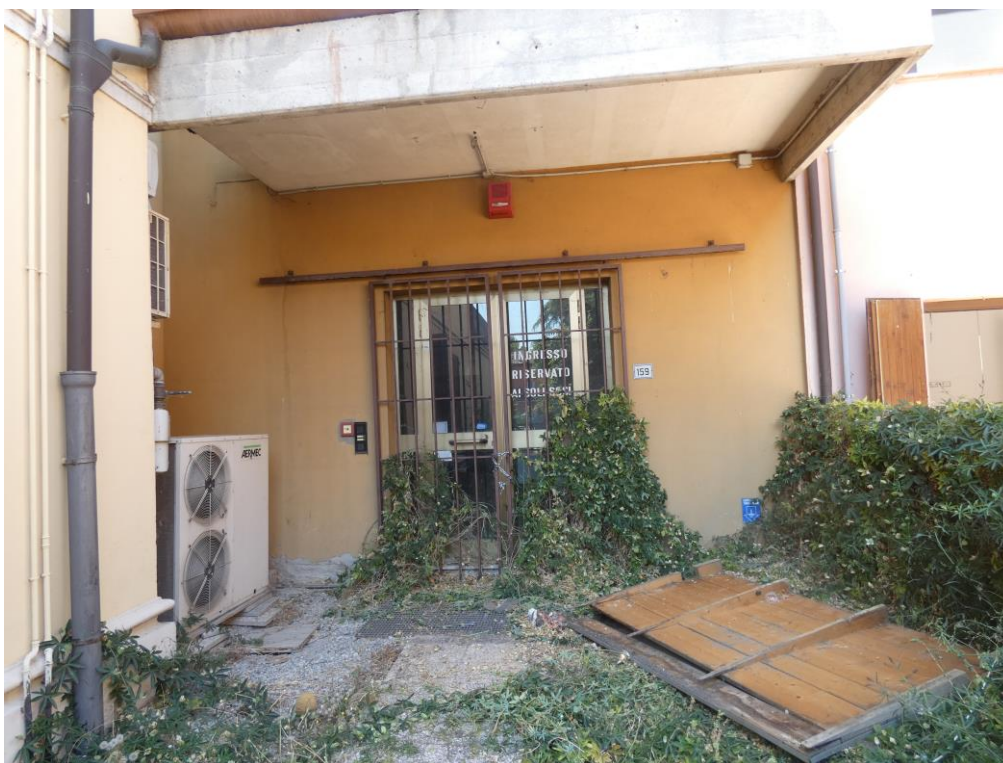
Presa fotografica 01 – Vista Esterna dell'area cortiliva/ingresso del fabbricato da Sud
