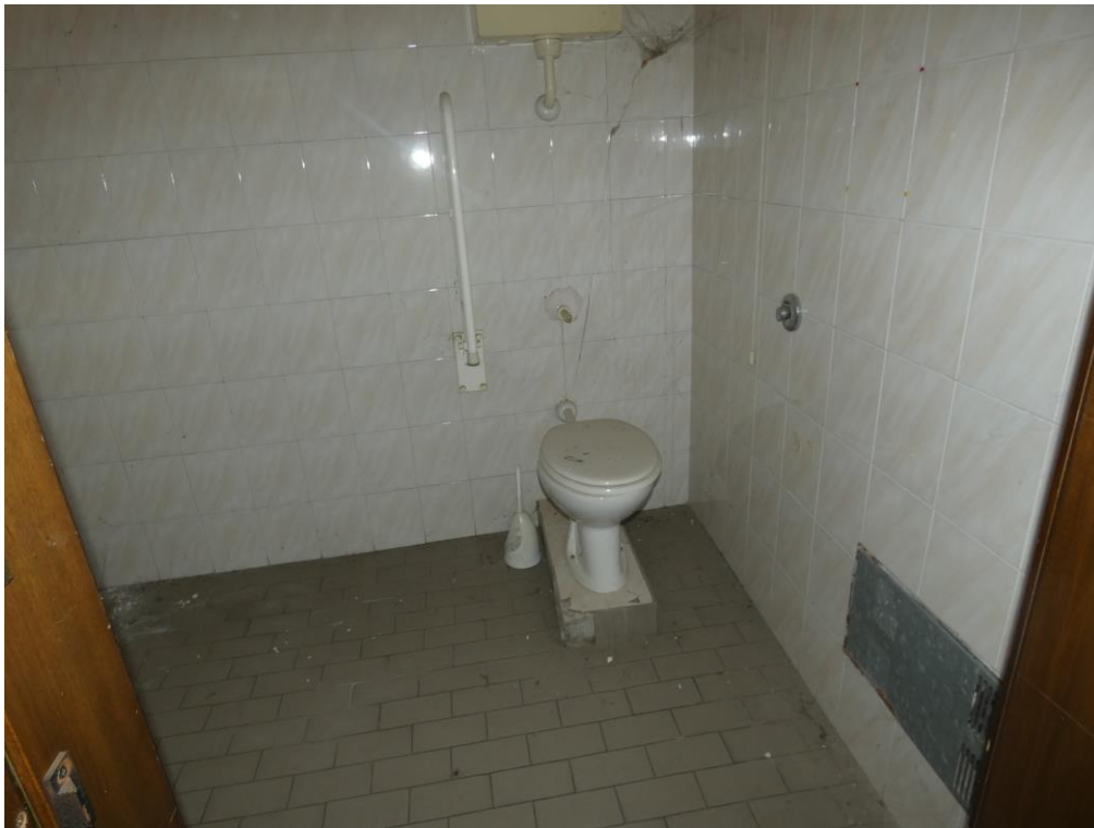
Presa fotografica 58 – Vista Interna W.C.
