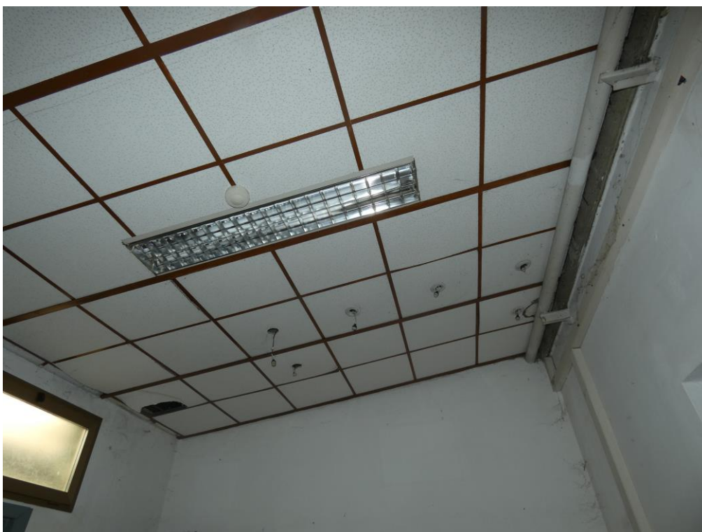
Presa fotografica 10 – Vista Interna: Intradosso controsoffitto del solaio piano primo
