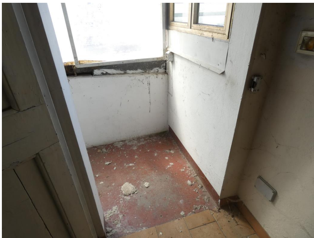
Presenza fotografica 72 – Vista Interna da Ufficio al Vano scala
