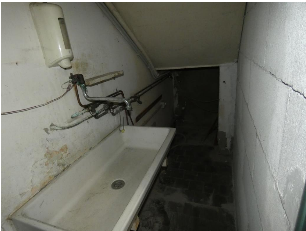
Presa fotografica 12 – Vista Interna: Vano sotto scala
