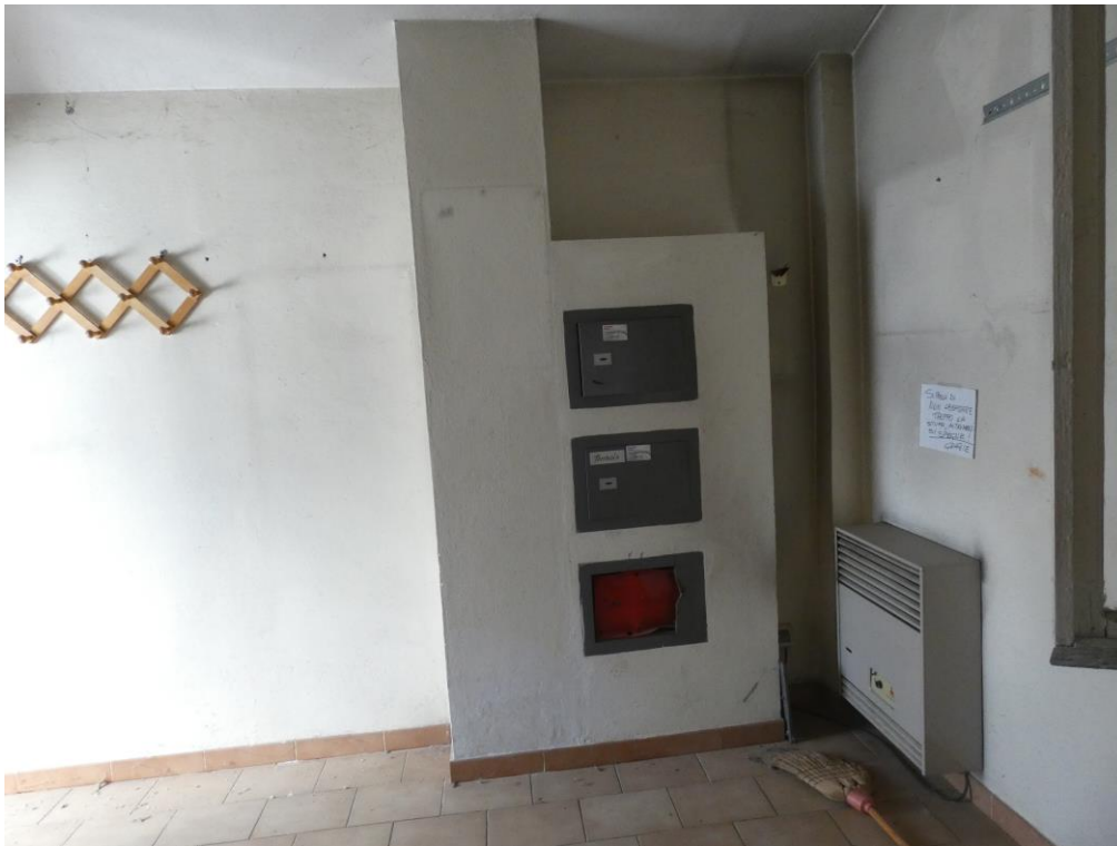
Presafotografica 70 – Vista interna Ufficio: Dettaglio pilastro e cassaforte
