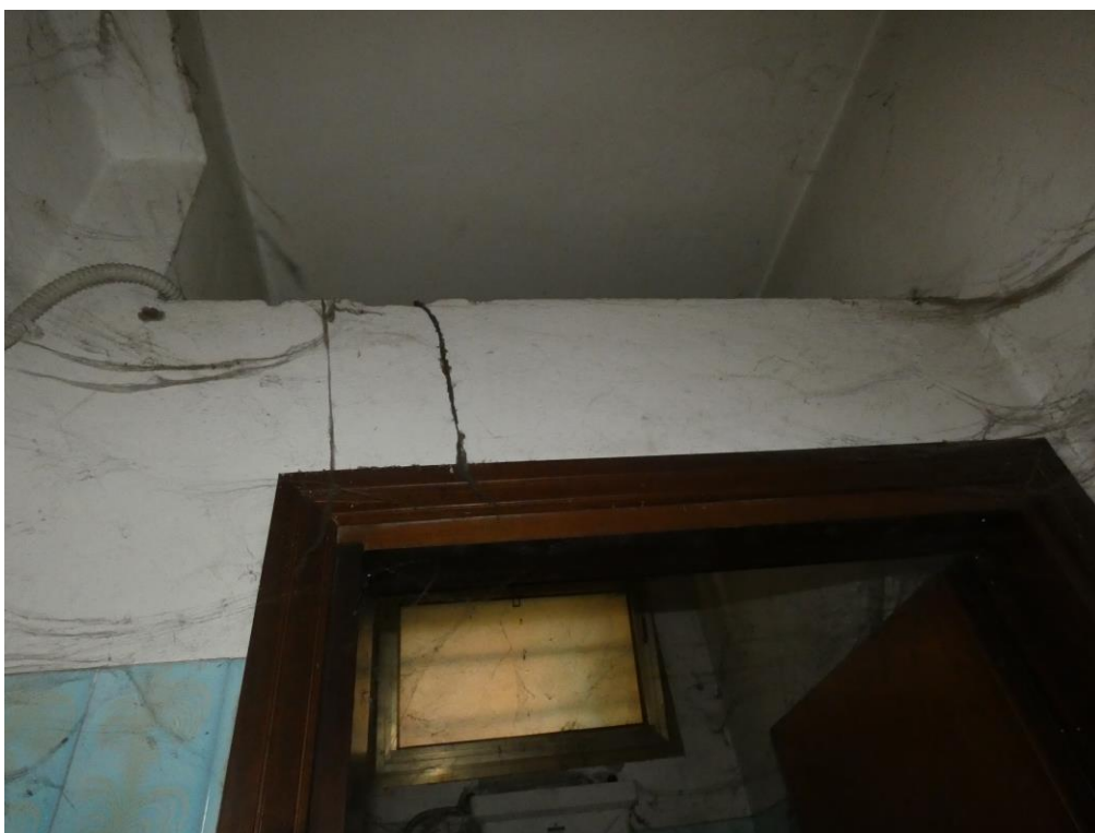
Presenza fotografica 37 – Vista Interna W.C.: Intradosso del solaio del Piano Primo
