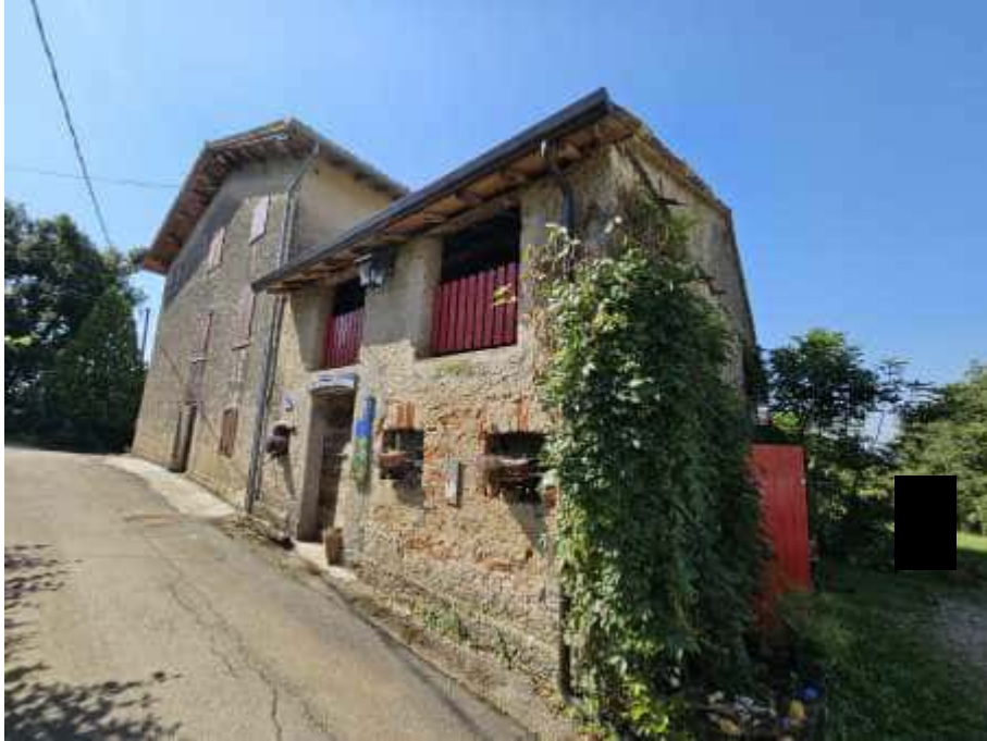
FOTO 1 : vista esterna lato nord-ovest
