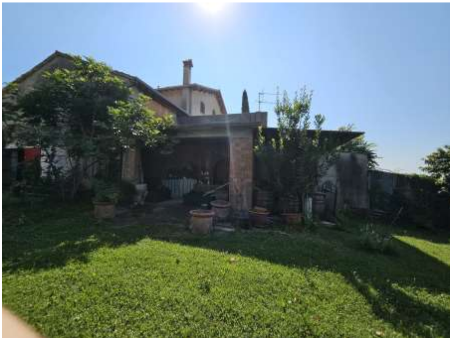
FOTO 2 : vista esterna lato ovest
