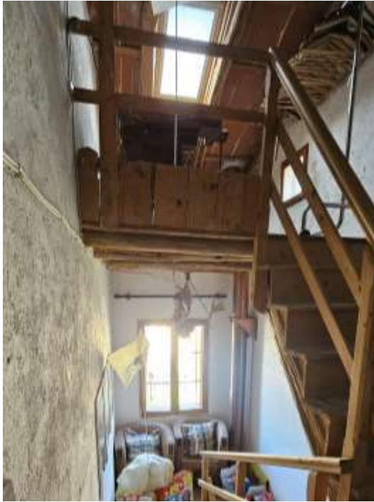
FOTO 13: vista vano scale
