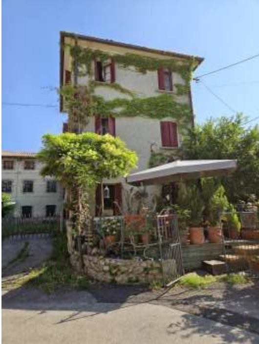
FOTO 1: vista prospetto sud
