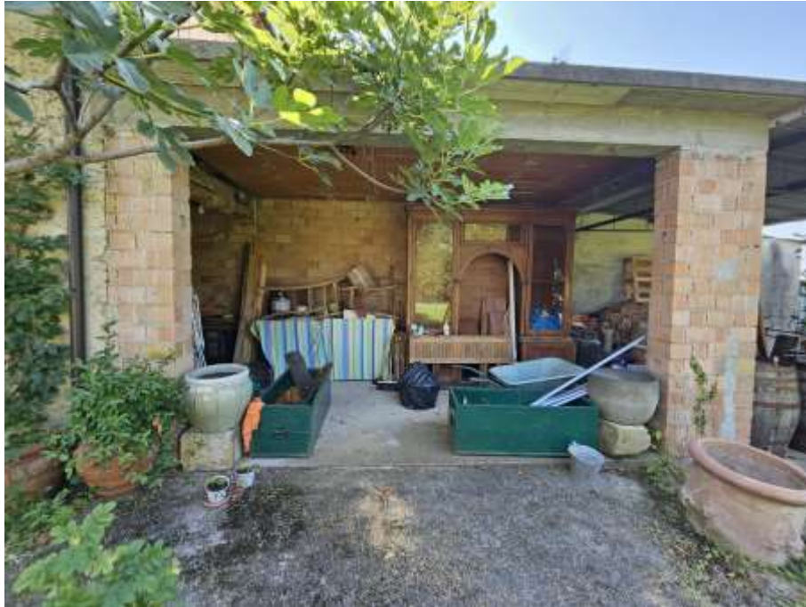
FOTO 3: vista esterna lato ovest
