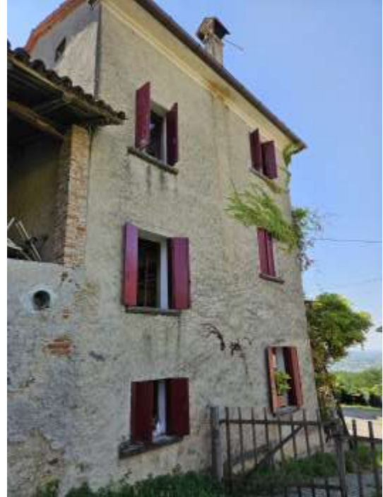
FOTO 2: vista prospetto ovest
