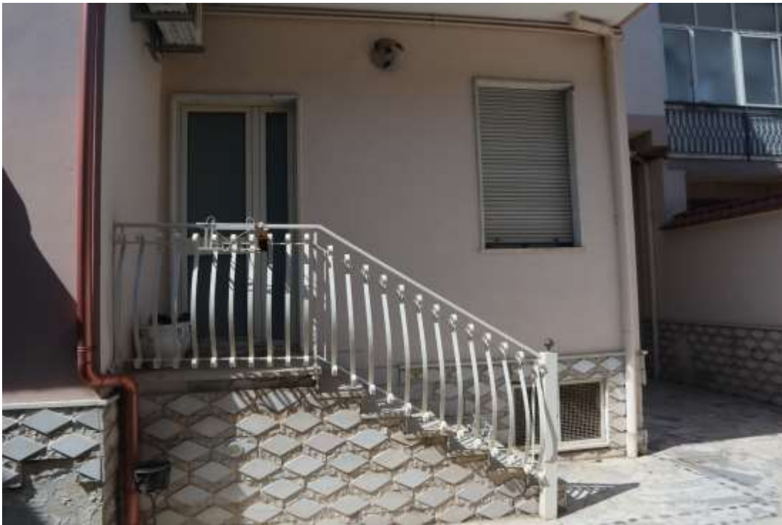
BALCONCINO SU CORTE INTERNA
