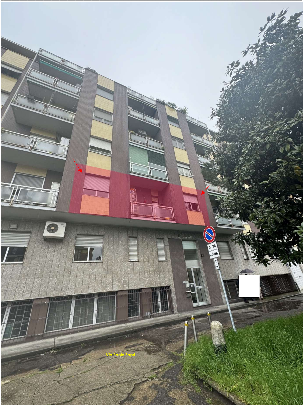
Foto n. 1. Appartamento per civile abitazione al piano primo con annesso solaio al piano sesto (sottotetto), identificato al Catasto Fabbricati al foglio n. 90 ptc. n. 99 sub . n. 7, sito nel Comune di Milano (MI), zona Certosa, alla Via Sapi n. 14/6. Palazzina condominiale
