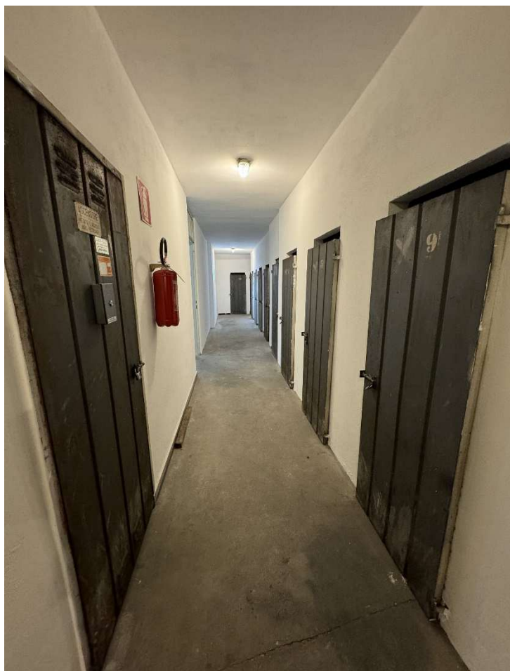
Foto nn. 36-37. Piano Sesto (sottotetto). Solaio e corridoio comune
