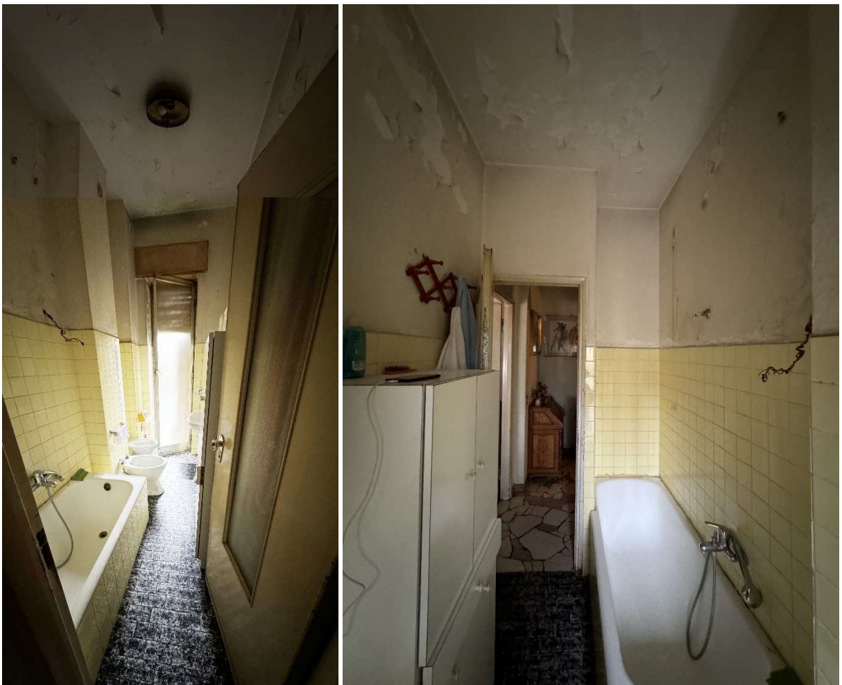
Foto nn. 21-22. Piano Primo. Bagno
