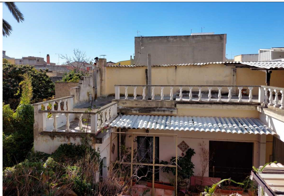
18. Piano primo, vista dalla veranda (vano n. 10 nella planimetria dello stato di fatto, all. 3, tav. 1).
