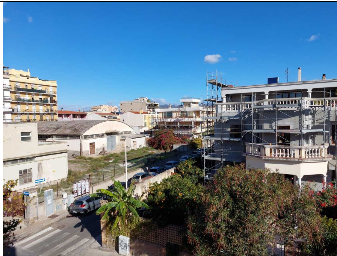
35. Piano secondo, vista dal balcone (vano n. 15 nella planimetria dello stato di fatto, all. 3, tav. 1).
