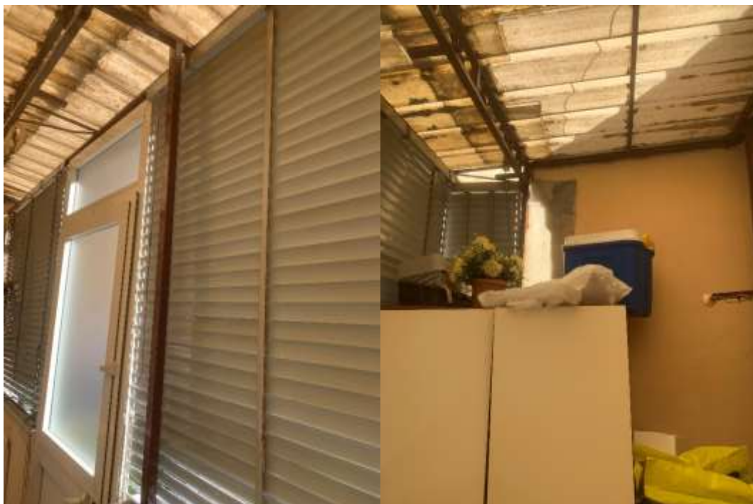
FIGURA 22/25: RILIEVO FOTOGRAFICO DEL INGRESSO AL CESPITE
