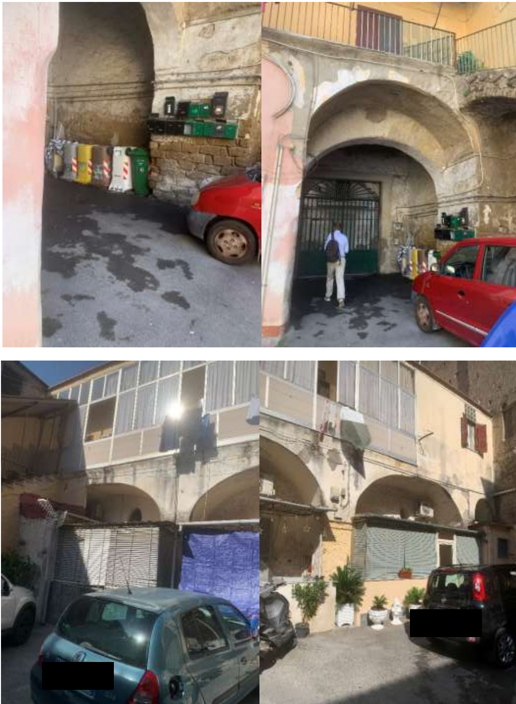
FIGURA14/17: RILIEVO FOTOGRAFICO DEL CORTILE
