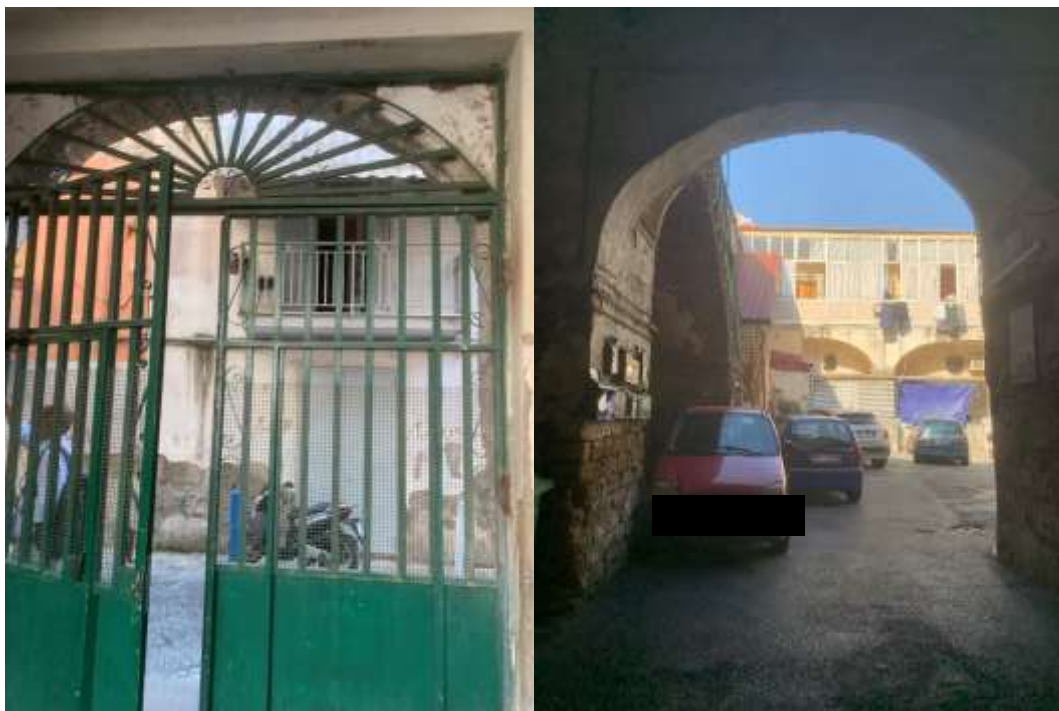
FIGURA7/10: RILIEVO FOTOGRAFICO DEL FABBRICATO E ANDRONE
