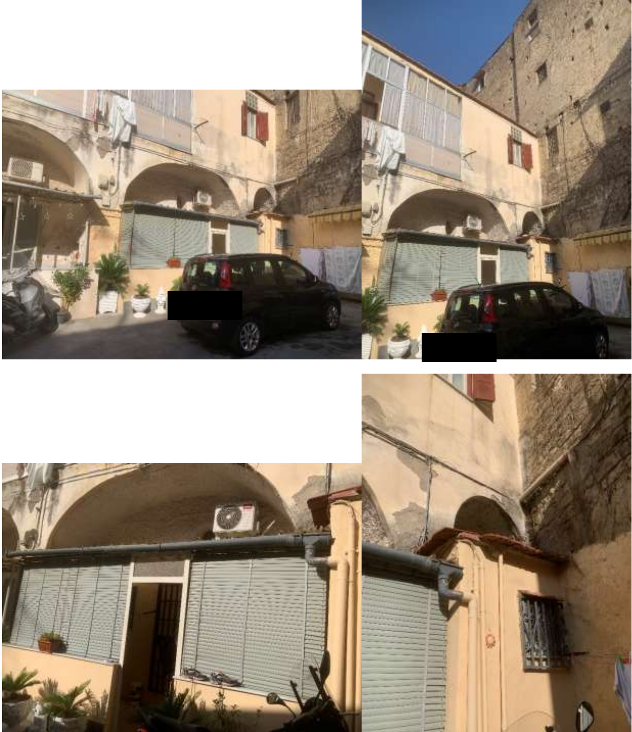
FIGURA18/21: RILIEVO FOTOGRAFICO DEL CORTILE CON INGRESSO AL CESPITE
