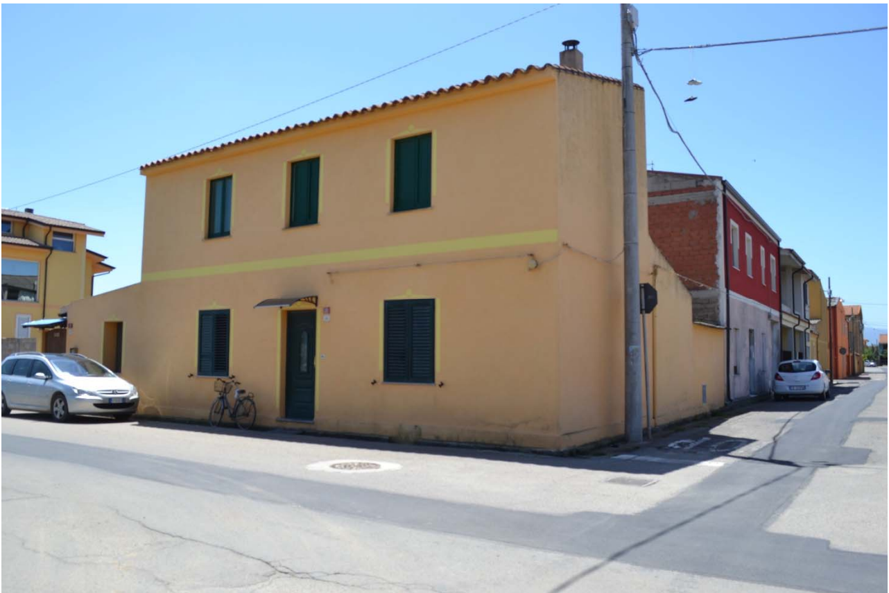
2. Prospetto del fabbricato in oggetto
