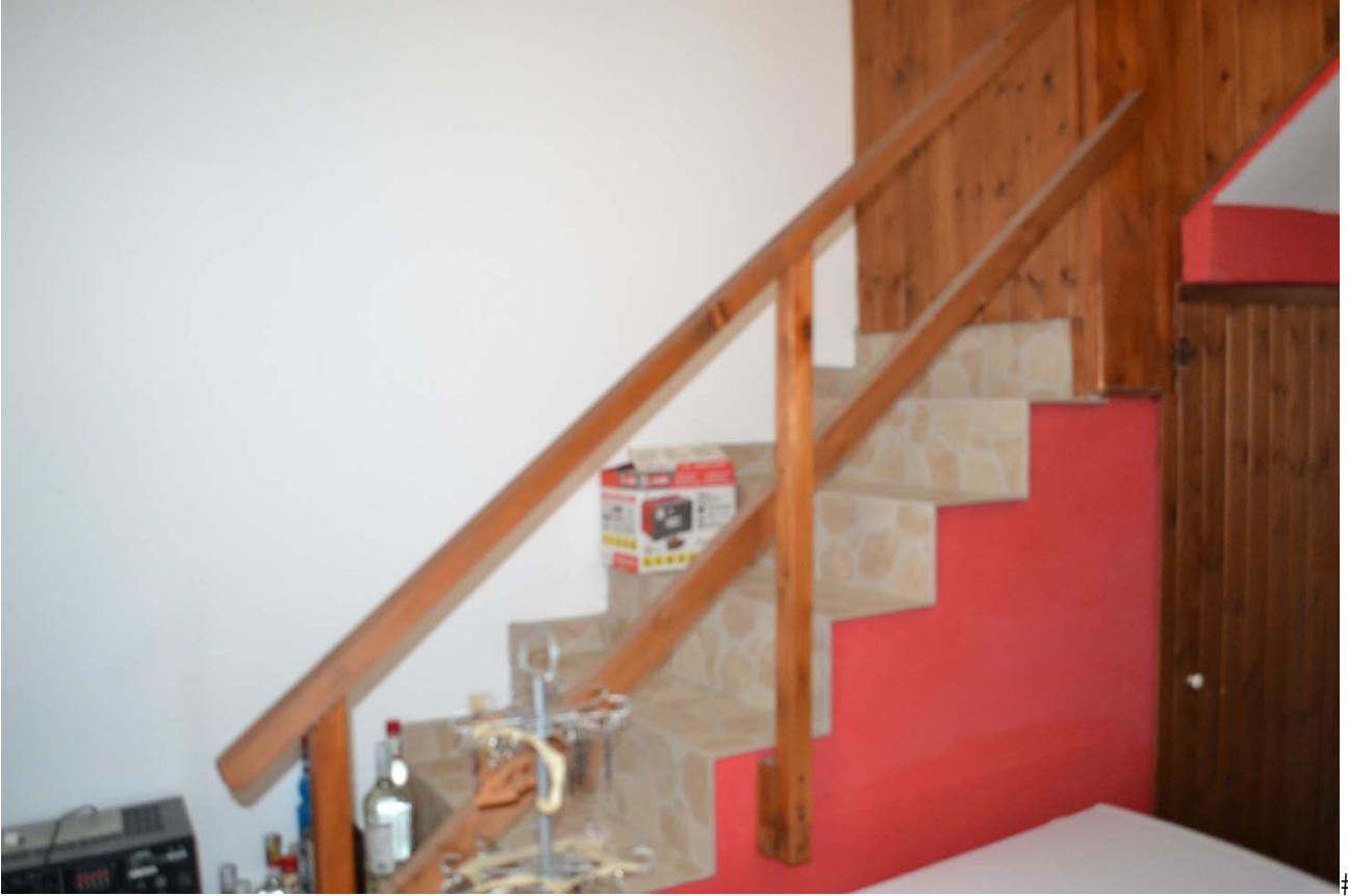
15. Scala di accesso al piano primo
