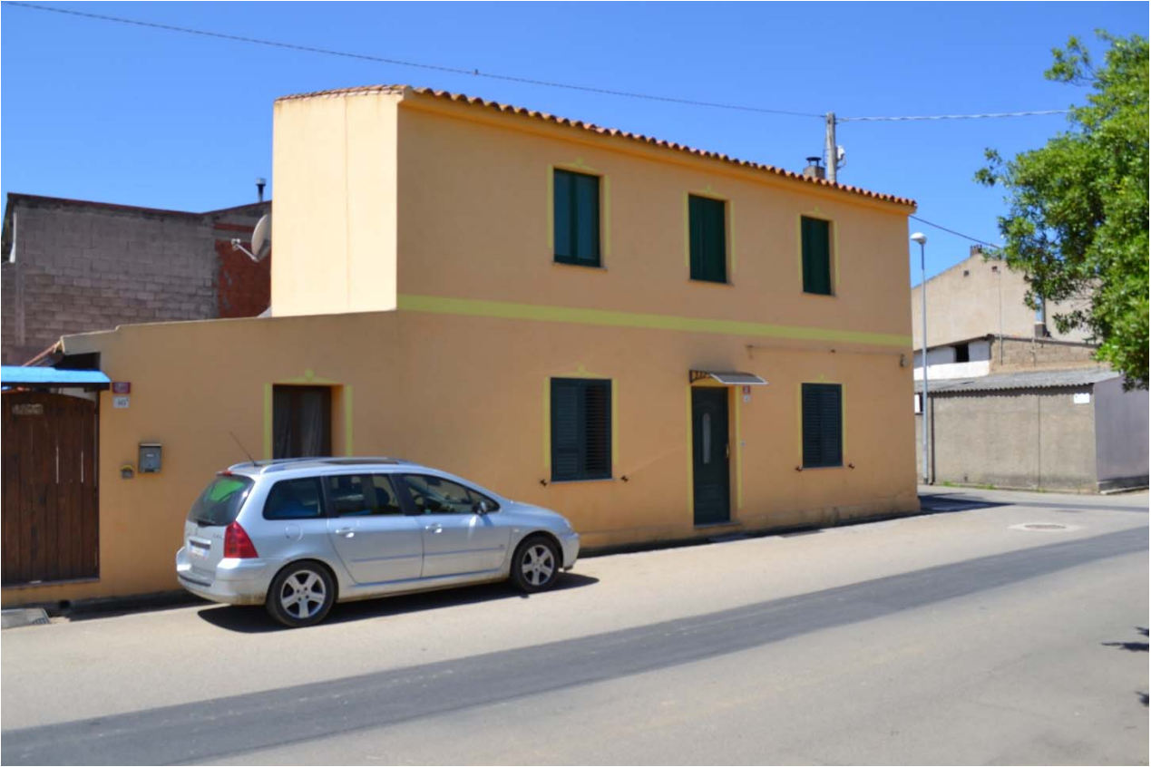
1. Prospetto del fabbricato in oggetto
