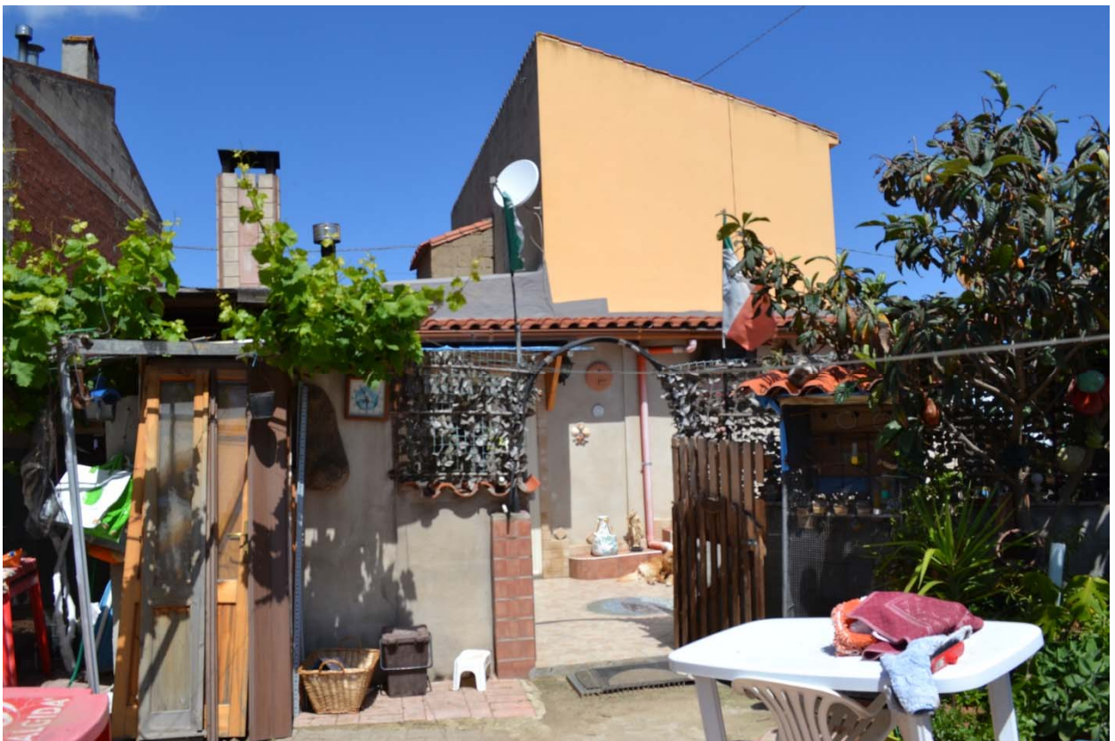
4. Vista del cortile in oggetto
