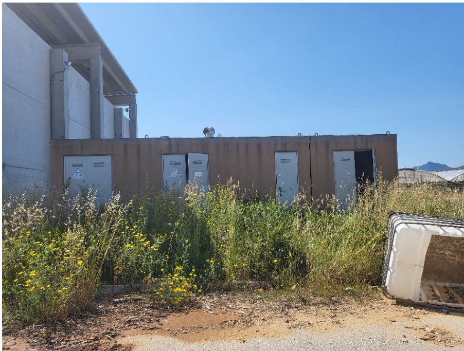
Foto 13: cabina connessione rete elettrica
