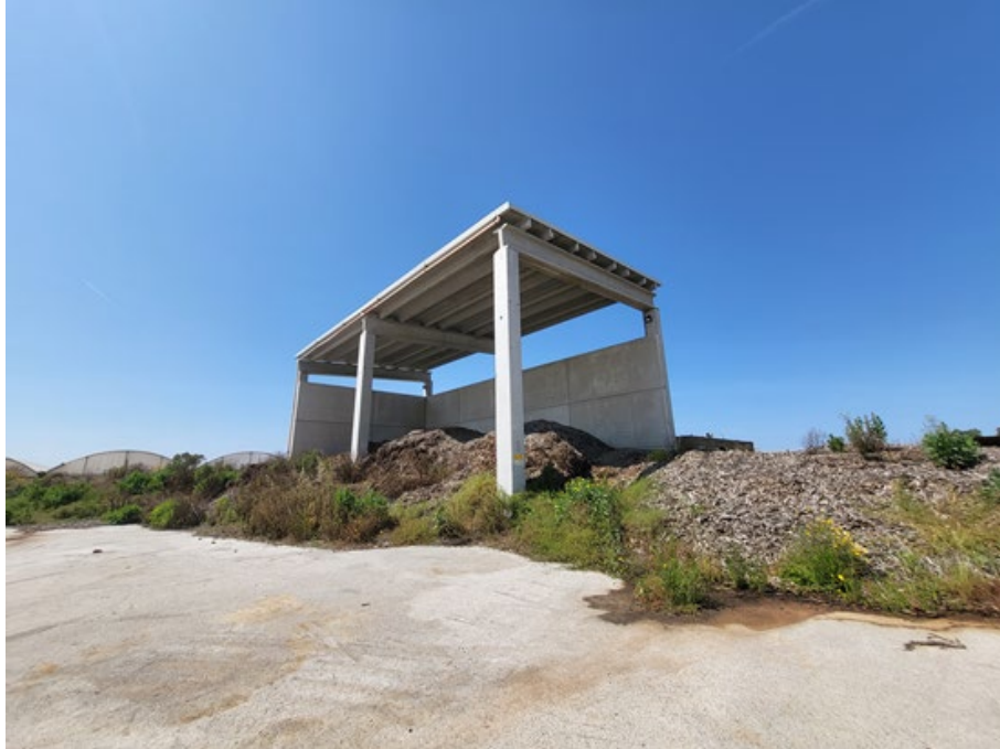
Foto 12: edificio stoccaggio cippato
