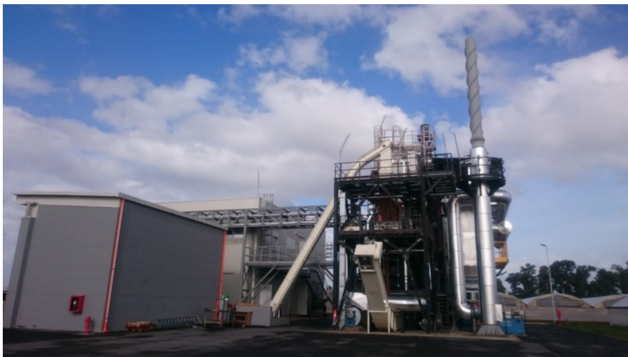
Foto 1: impianto a biomassa
