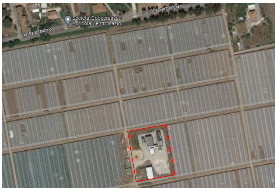
Figura 3: centrale a biomassa
