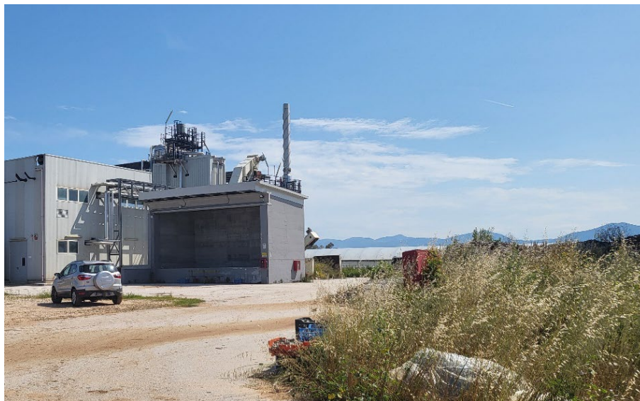
Foto 5: sistema carico e scarico automatizzato
