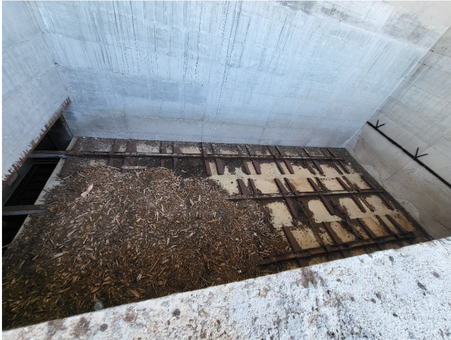
Foto 6: particolare sistema carico e scarico (moving floor)
